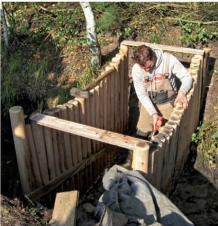
Abb. 8: Bau von Stauen,
