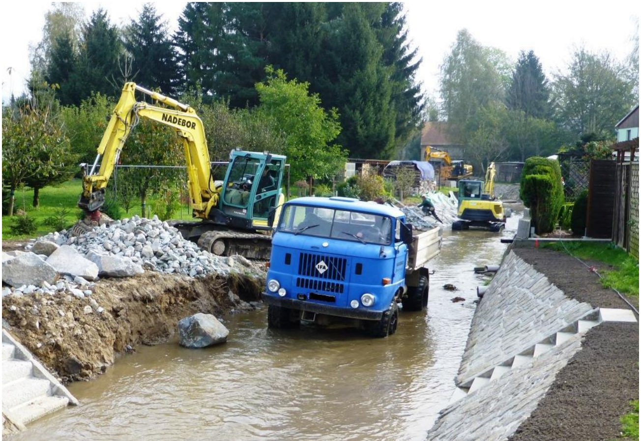
Abbildung 2: Gewässerinstandsetzung der Wesenitz im Herbst 2014 – Bauen in der gesetzlichen Schonzeit der Bachforelle
