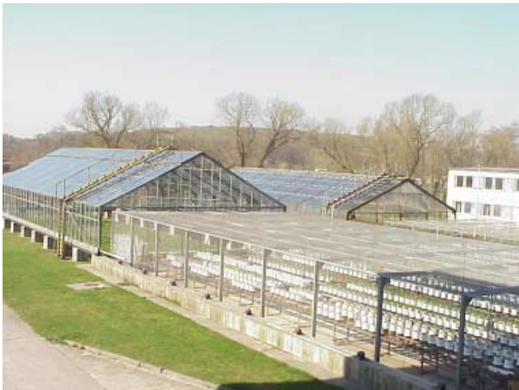
Gefäßstation – 1200 Gefäße, Rolldächer und automatische Bewässerungsanlagen
