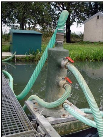
**Abbildung 9:** Luftverteilereinheit auf die HP-Förderer
