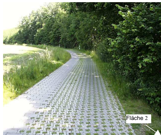
Abbildung 2-38: Zufahrt LPG-Straße zu Fläche 2 (06/2001)
