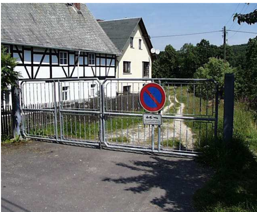
Abbildung 2-31: Neu angebrachtes Tor an Zufahrt zu Fläche 1 (Talsperrenvorstau, Fläche 1 – 06/2001)
