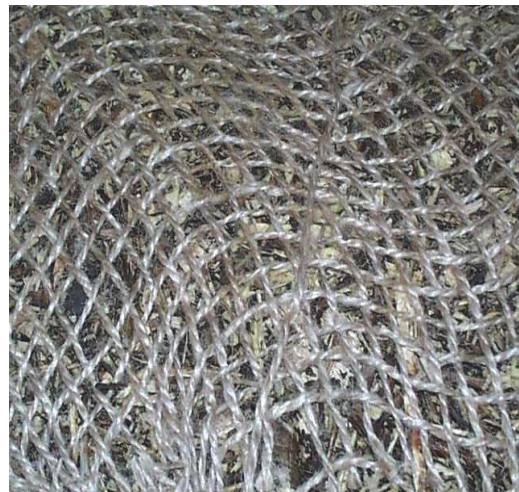
Abbildung 5-24: Außenseite der Baumschutzmanschette mit Jute-Gewebe
