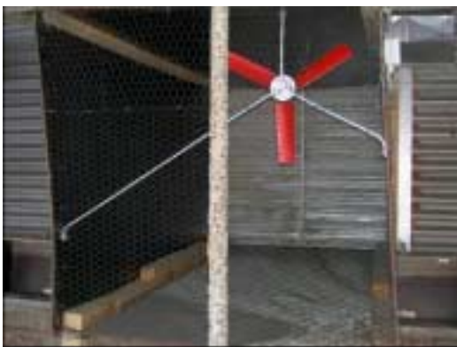
Abbildung 7-5: Messventilator mit Abströmkanal
