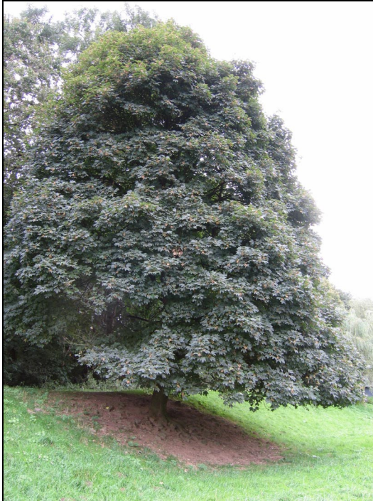
Abbildung 3-35: Deutlich schlechter ausgebildete Grasnarbe unter einem Baum auf einem Deichabschnitt
