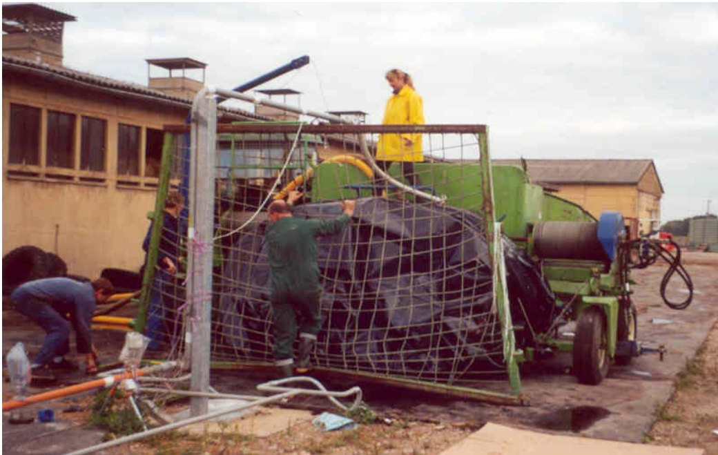
Abbildung 3.1.1-2: Vorarbeiten zur Schlauchbefüllung (Variante ohne Bodenheizung)
