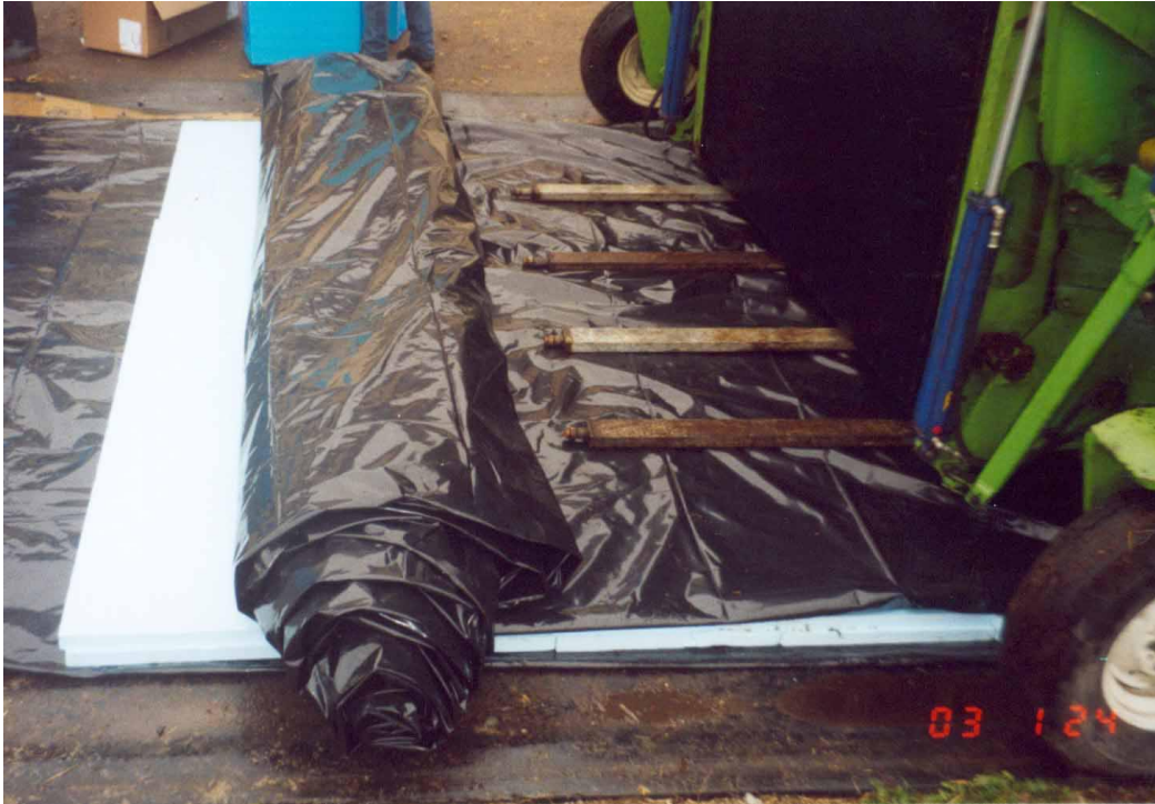
Abbildung 5.7-1: Wärmedämmung mit Dämmstoff Roofmate
