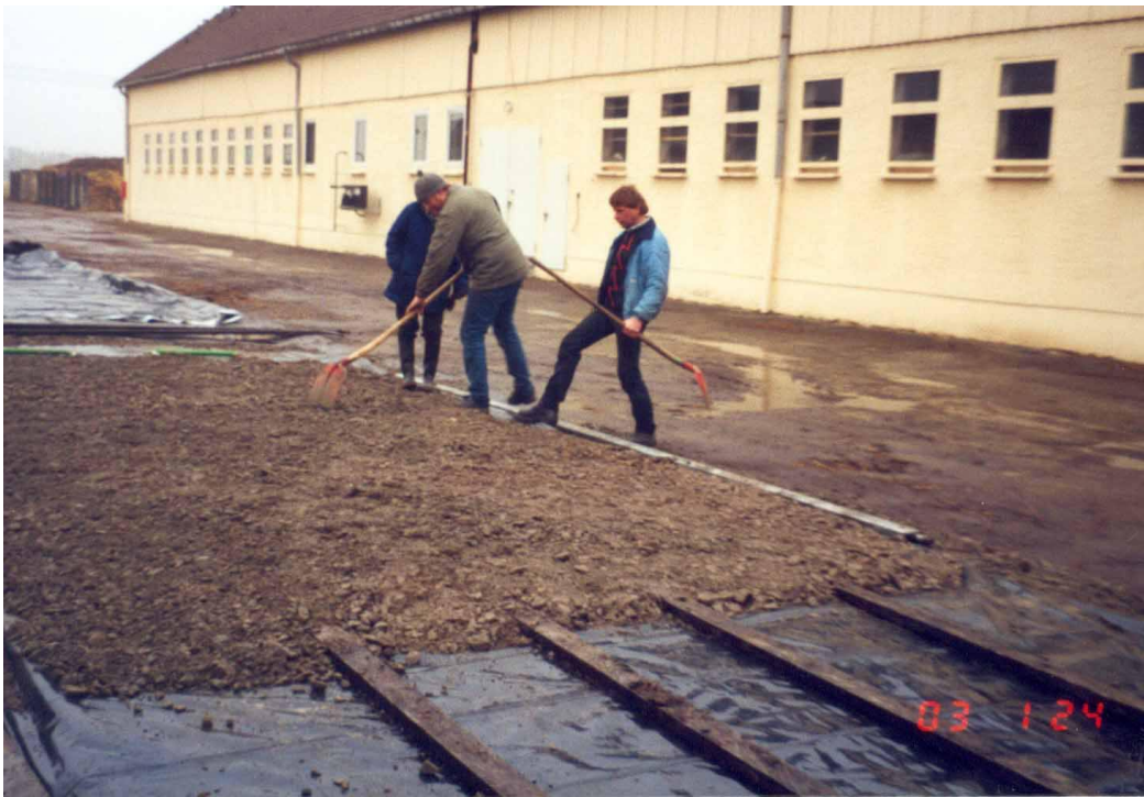
Abbildung 5.7-2: Wärmedämmung mit Dämmstoff Schotter
