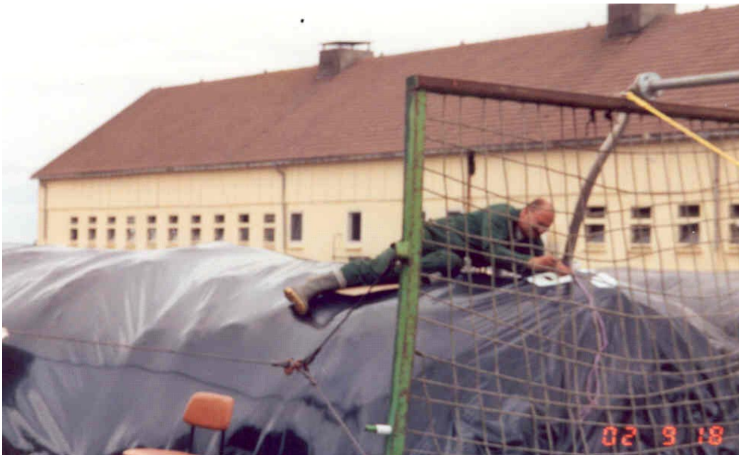
Abbildung 3.1.3-1: Einsetzen des Ventils zur Gasableitung
