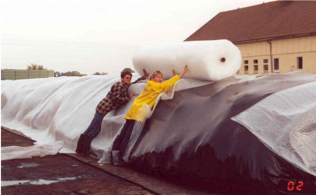
Abbildung 3.1.3-2: Isolieren des Schlauches
