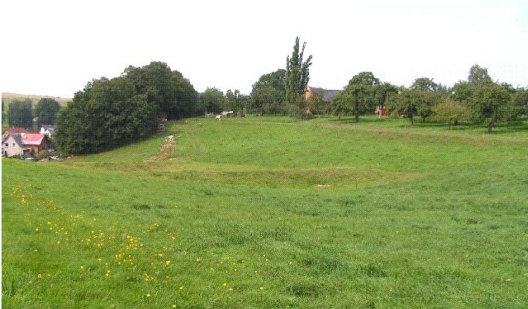
Abbildung 18: Rückhaltedämme in Niederfrohna 116
