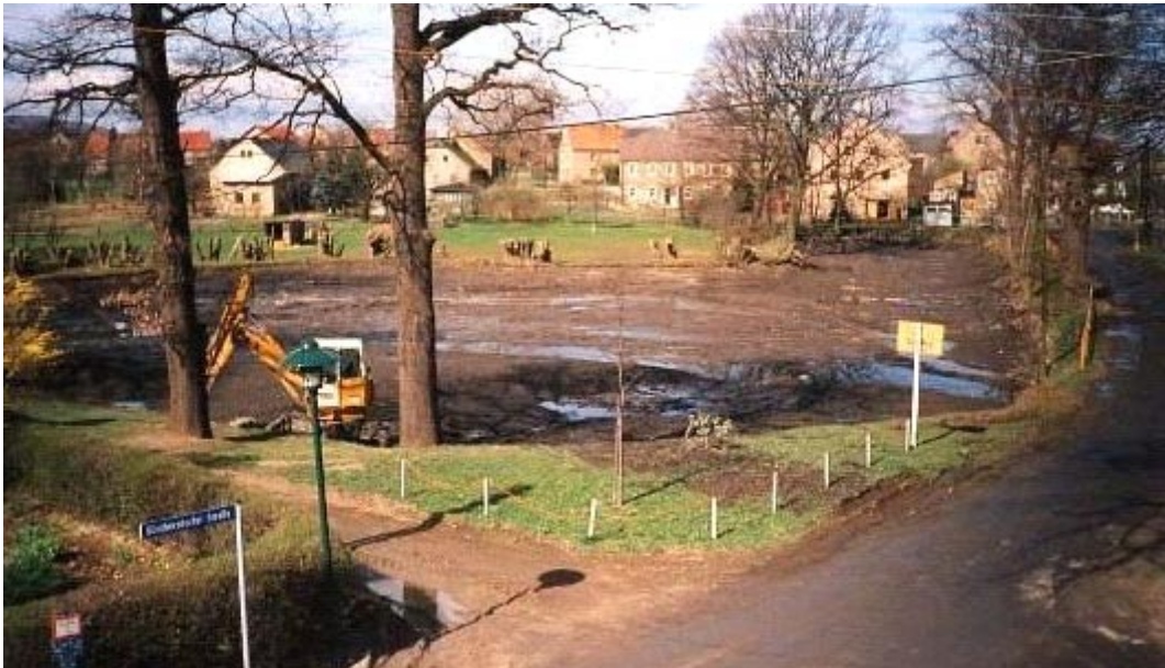
Abbildung 27: Der Mühlteich Günthersdorf während der Sanierung 130
