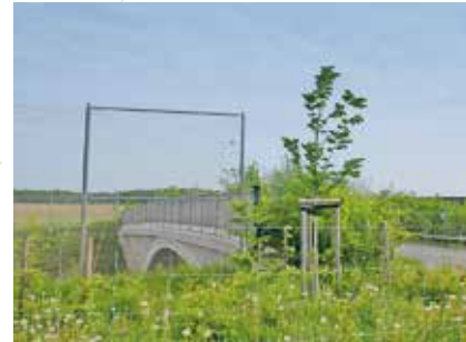
Begrünte Brücken über die S 170 n bieten Querungshilfen und Leitstrukturen für Insekten und Kleinsäuger.
