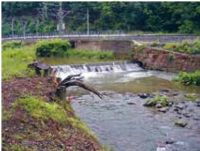
Das Weißeritzwehr vor und nach den Maßnahmen aus dem Durchgängigkeitsprogramm.
