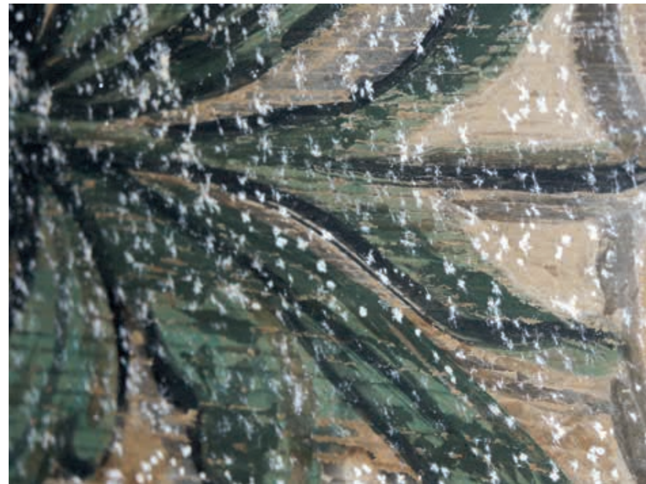
Hylotoxausbildungen (DDT-Kristalle) auf einer bemalten Holzbalkendecke
