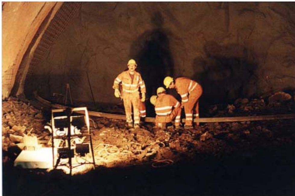
Abbildung 20: Beleuchtungsbock mit vier Scheinwerfern vor der Ortsbrust
