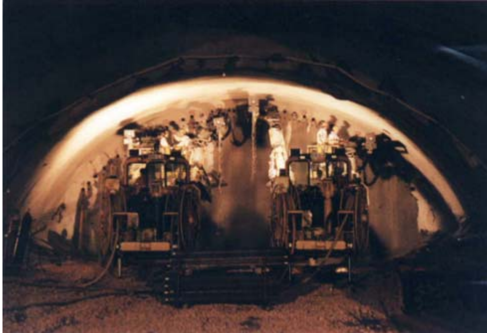
Abbildung 10: Einbringen des Rohrschirms
