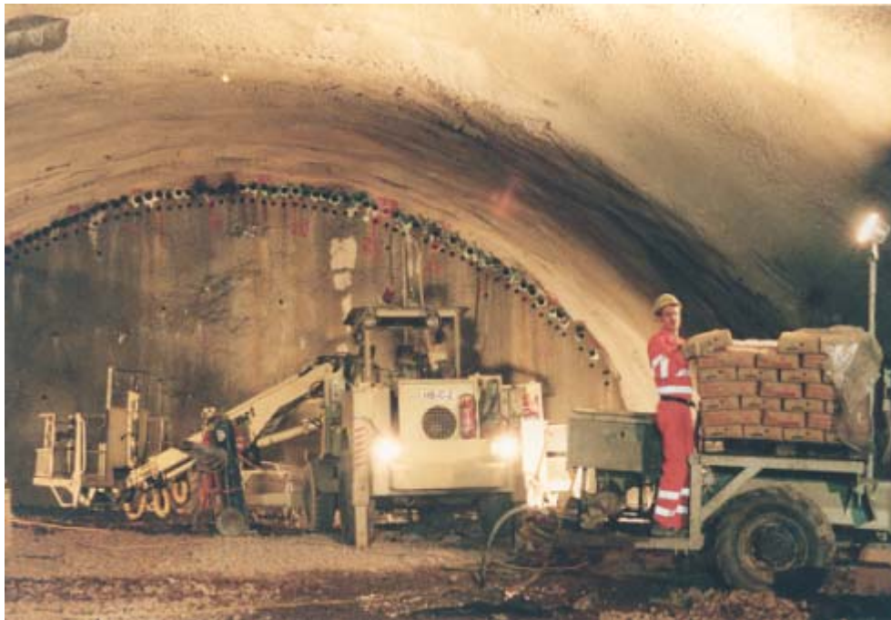
Abbildung 11: Verpressen der Rohre und Spalten mit Zement-Wasser-Emulsion
