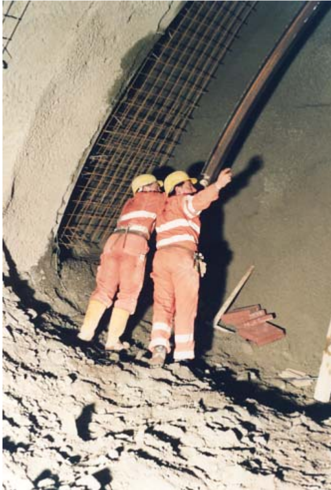
Abbildung 8: Setzen des Stahlbogens und der Armierung
