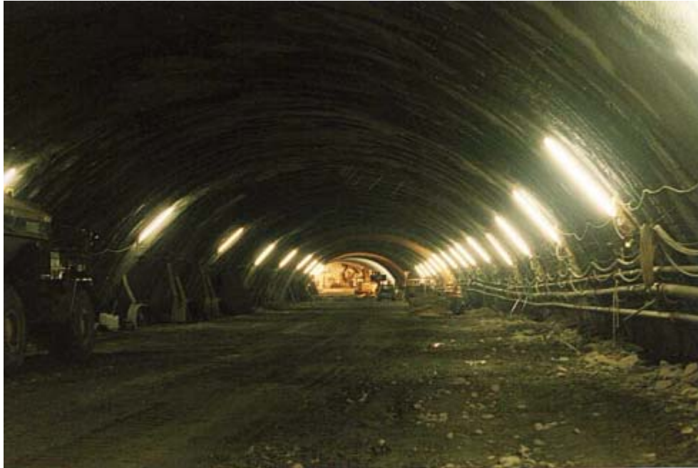
Abbildung 18: Neue vertikale Anordnung und Verteilung von Leuchten
