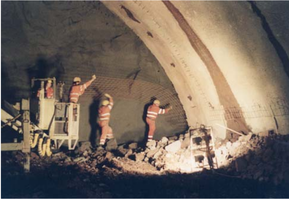
Abbildung 6: Anbringung der Bewehrungsmatten an das Tunnelgewölbe
