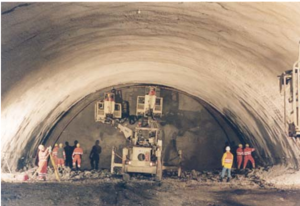
Abbildung 7: Aufrichten eines Stahlbogens mit einer Arbeitsbühne
