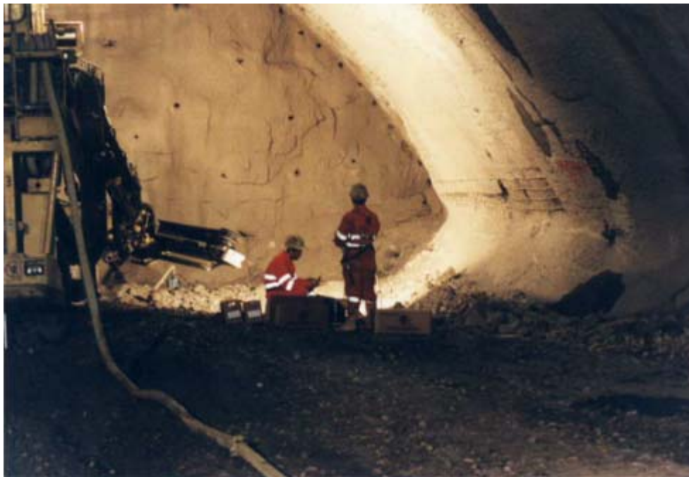
Abbildung 3: Bereitstellung des Sprengstoffs zum Besetzen der Bohrlöcher
