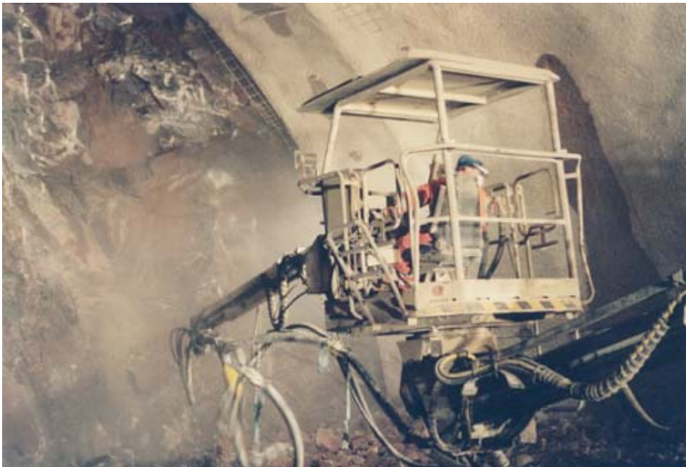
Abbildung 5: Aufbringen von Spritzbeton auf die Ortsbrust (Versiegeln)
