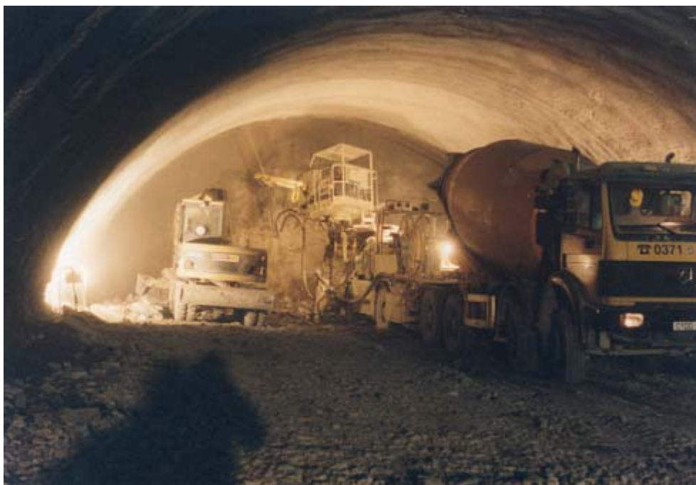
Abbildung 9: Aufspritzen der Betonschale mit dem Spritzmobil
