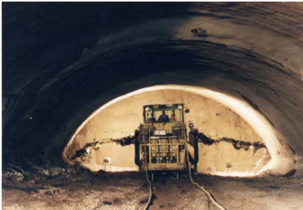
Abbildung 2: Bohren der Sprenglöcher mit einem zweiarmigen Bohrwagen
