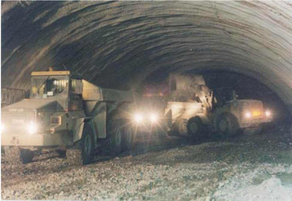
Abbildung 4: Schuttern des Haufwerks mit Radlader und Muldenkipper
