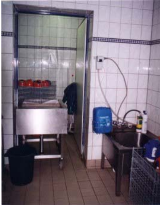
Bild 17: Mit dem Vorweichbecken verstellter Durchgang zum Abfallraum
