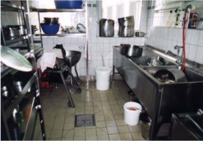
Bild 19: Blick in den Topfspülraum
