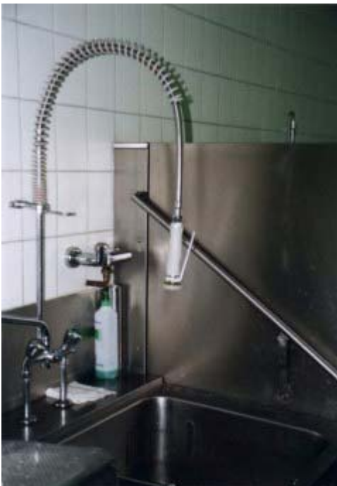
Bild 20: Eine federnde Aufhängung der Handbrause vermindert die statische Haltearbeit (Gestaltungsvorschlag)
