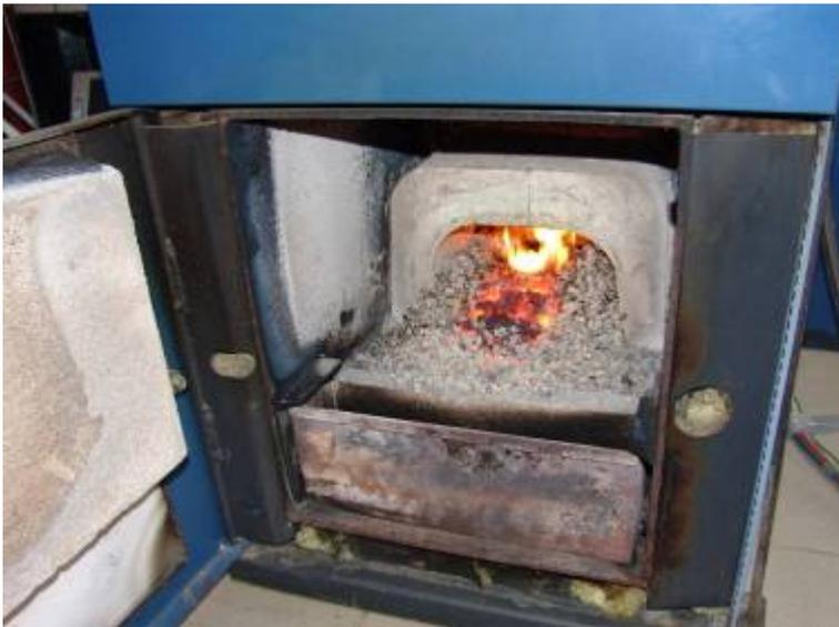
**Abbildung 25: Brennraum des Kessels (Baxi MULTI HEAD 25 kW)**
