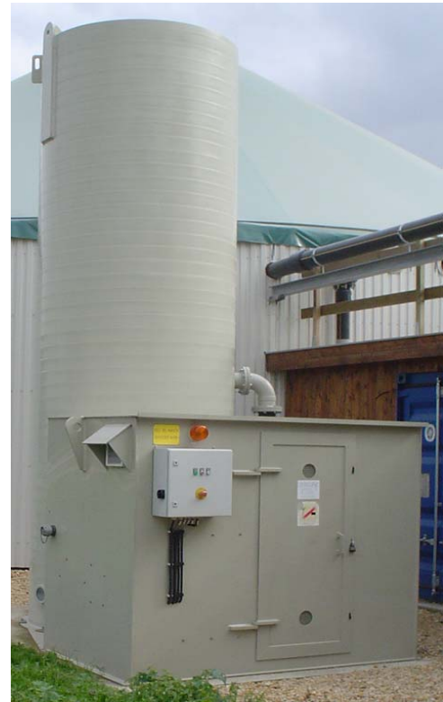
Abbildung 27: Tropfkörper-Biorieselbettreaktor
