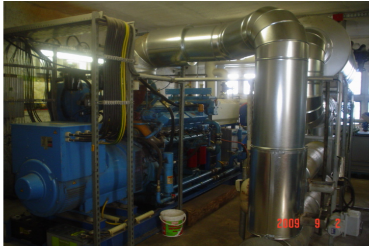
Abbildung 18: BHKW mit der Caterpillar-Motorspezifikation „G 3412 TA“ (Datenbanknummer „40“)
