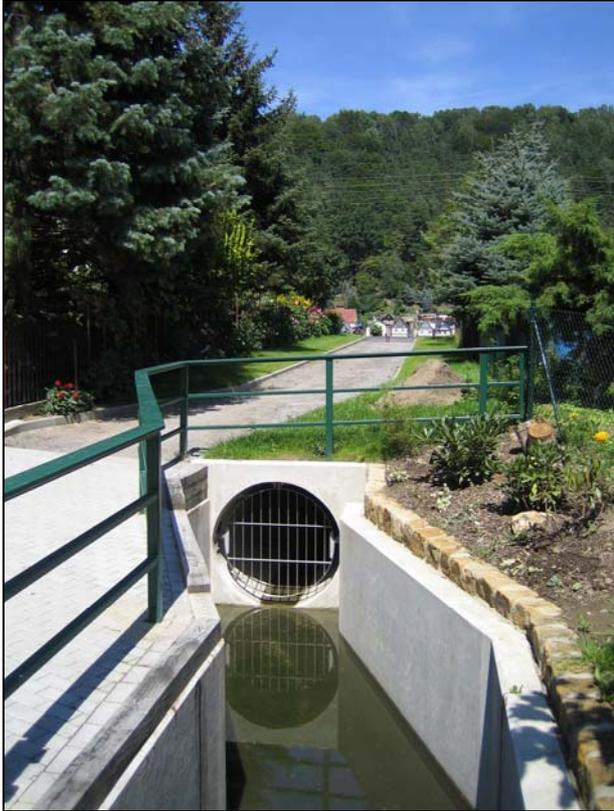
**Abbildung 13: Einlass in das Entwässerungsrohr in Richtung Elbe**
