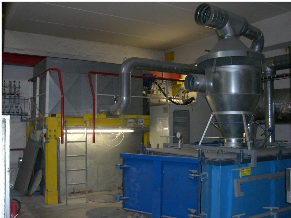
**Abbildung 42: Zirkulierende Wirbelschicht des CUTEC-Institutes**
