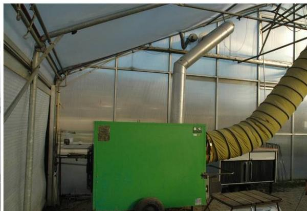
Abbildung 6: Heizung Remco CLA 100 mit Gas
