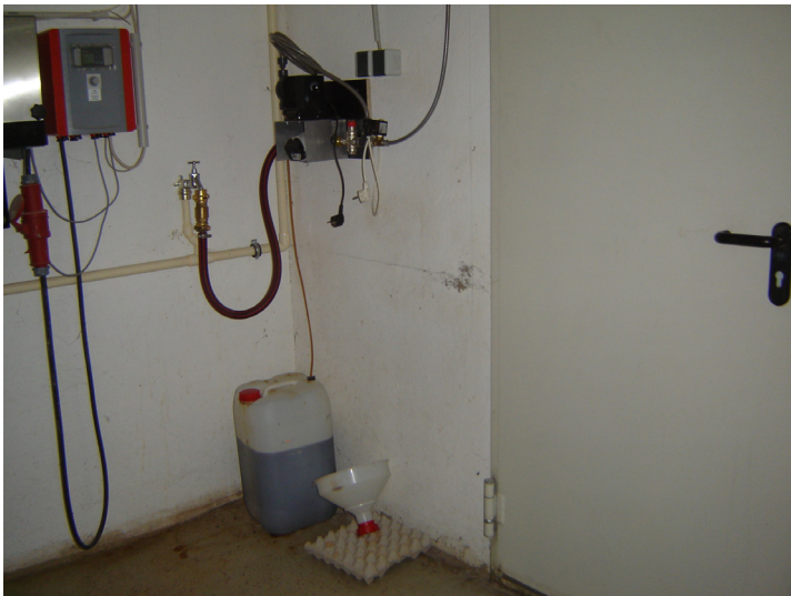
Abbildung 14: Steuer- und Applikationseinheit mit Vorratsbehälter und Zuführung zur Fütterschnecke im Stall
