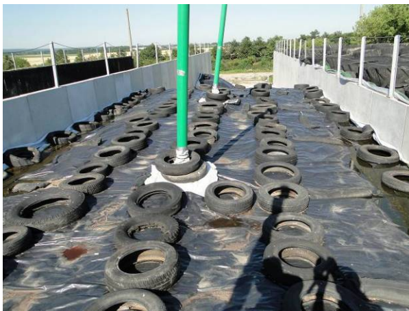
Abbildung 67: Gesamtansicht Trockenmiete am 28.06.2011
