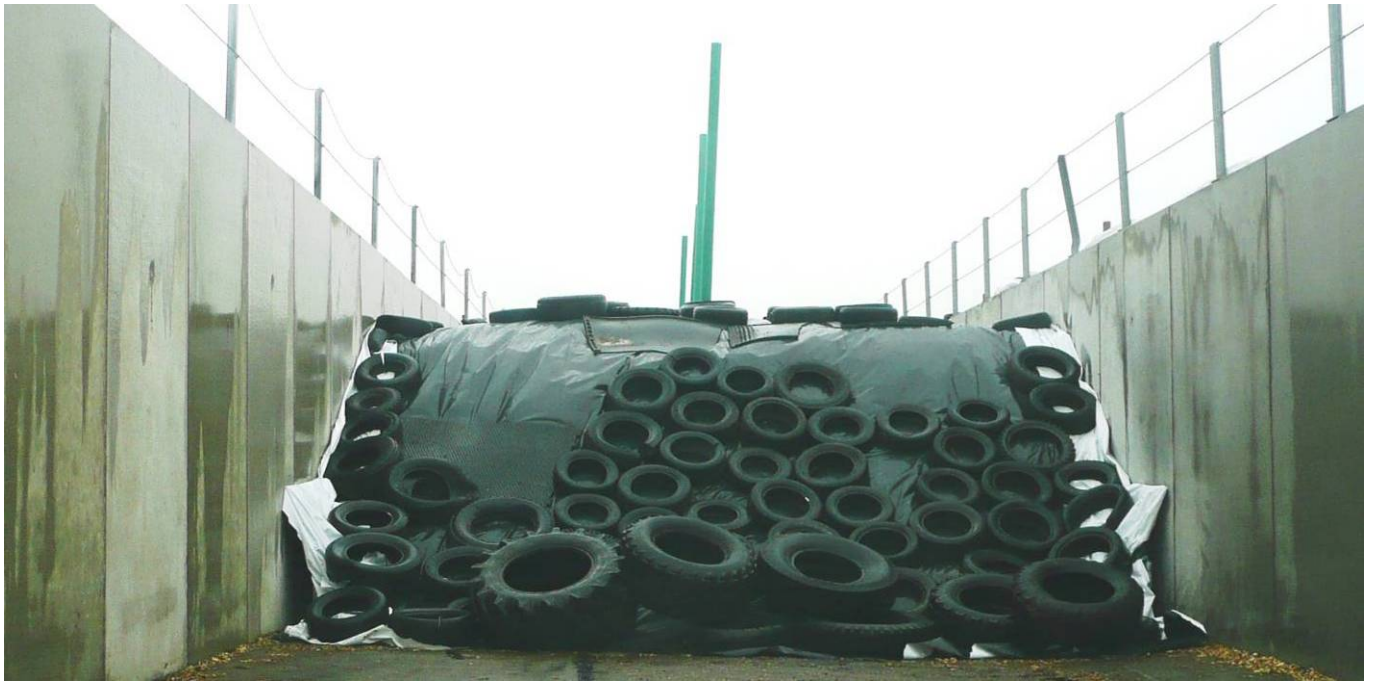
Abbildung 66: Trockenmiete nach Abschluss der Einlagerung und der Abdeckung in Köllitsch
