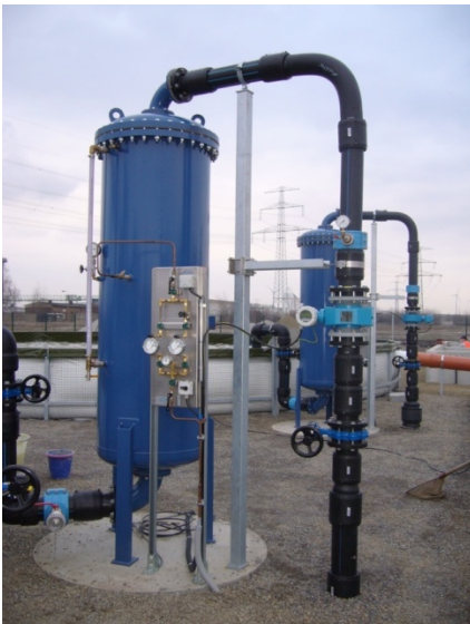
Abbildung 4: Strahlenreaktor zur Sauerstoffanreicherung
