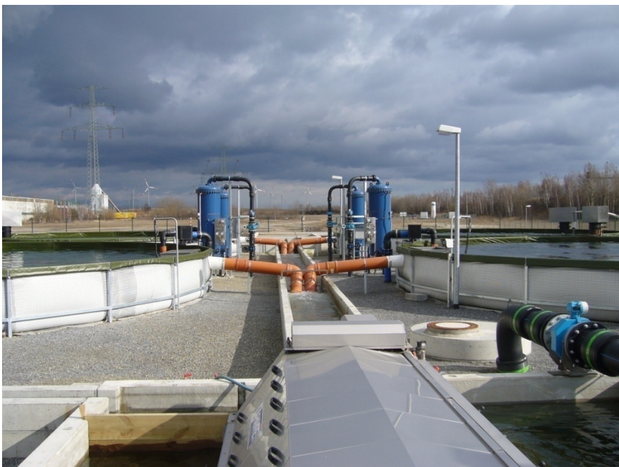
Abbildung 3: Blick vom Siebtrommelfilter auf die zentrale Ablaufrinne mit den Beckenabläufen der Satzkarpfenbecken mit je 175 m 3 Volumen
