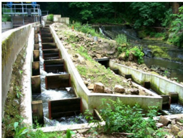
Abbildung 11: WKA Pirna Liebenthal an der Wesenitz: Vertical-Slot-Pass mit einem Schlitz 2
