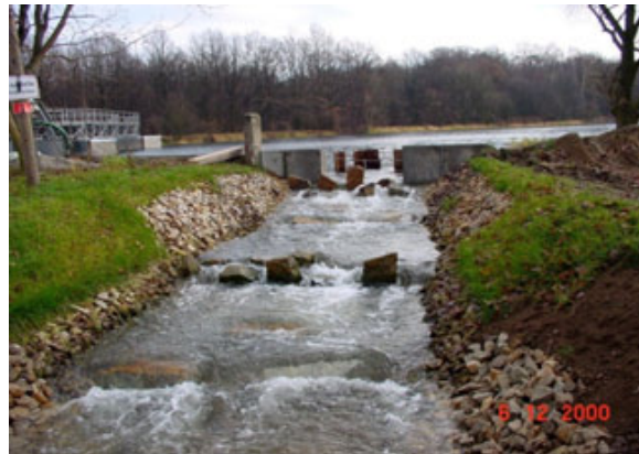
Abbildung 7: Umgehungsgerinne WKA Brehmenwerk (Lausitzer Neiße), Einstiegsbereich (links) Umgehungsgerinne WKA Brehmenwerk, Ausstiegsbereich mit Einlaufriegel, Lausitzer Neiße (rechts) 2
