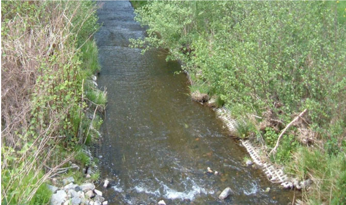
Abbildung 30: Durch wasserbauliche Maßnahmen verbauter, schwer degradierter Bereich unterhalb der Brücke Semmelmühle an der Triebisch, gekennzeichnet durch einen starken Rückgang der Individuendichten von Bachforelle und Elritze
