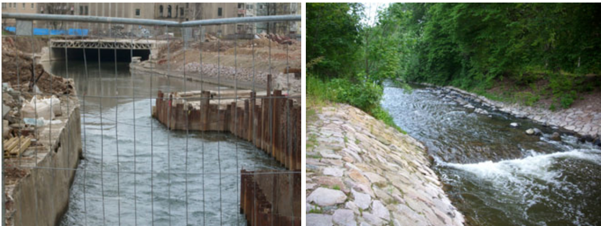
Deckelöffnung, Bereich Falkeplatz (links); Sohlgleite mit Fischrampe, Kauffahrtei (rechts)
