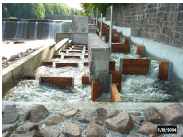
Abbildung 12: WKA Mittweida an der Zschopau: Vertical-Slot-Pass (Doppelschlitz) 2
