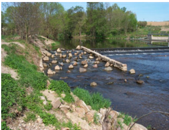
Abbildung 8: Mühle Pischwitz, Zschopau, Wehr mit Fischrampe (links) Wehr ehem. Schuhfabrik mit Fischrampe, Große Röder (rechts) 3
