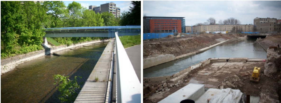
Abbildung 25: Sohlstrukturierung mit Balken, Georgbrücke (links); Deckelöffnung, Bereich Falkeplatz (rechts)
