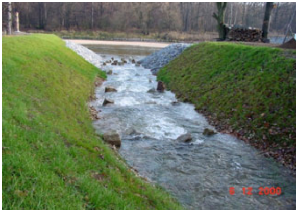
Abbildung 7: Umgehungsgerinne WKA Brehmenwerk (Lausitzer Neiße), Einstiegsbereich (links) Umgehungsgerinne WKA Brehmenwerk, Ausstiegsbereich mit Einlaufriegel, Lausitzer Neiße (rechts) 2
