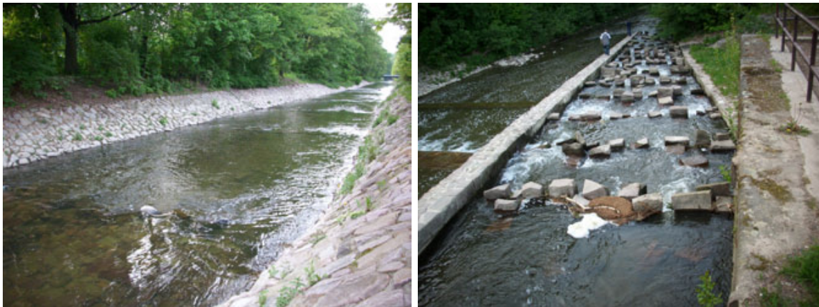
Sohlriegel mit Störsteinen, Kaufahrtei (links); Raugerinne-Beckenpass am Wehr Kaufahrtei mit Verklausungen (rechts)
