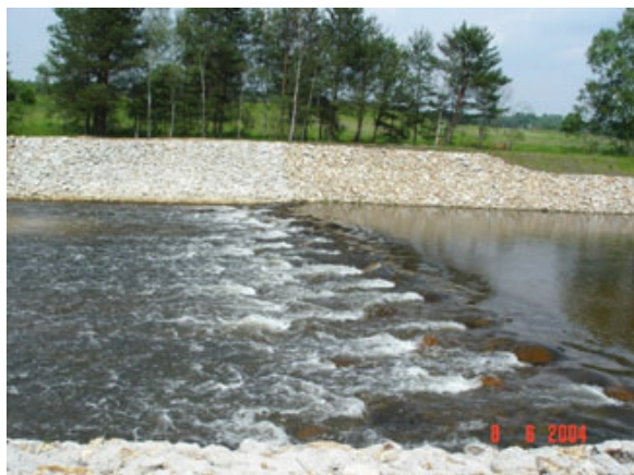
Abbildung 6: Sohlgleite an der ehem. Sohlenschwelle 15, Lausitzer Neiße (links) Sohlenrampe Paulsmühle in aufgelöster Bauweise (Riegelbauweise) an der Großen Röder (rechts) 1
