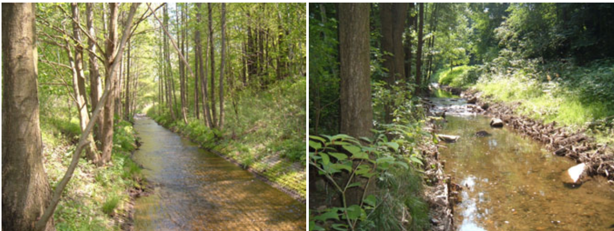
Abbildung 23: Mit Wabengitterplatten stark degradierter, ausgebauter Bereich unterhalb der Niedermühle (links); Struktur verbesserter Abschnitt nach Rückbau (rechts)
