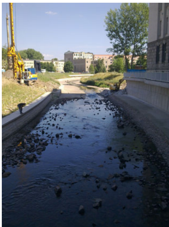
Abbildung 42: Chemnitz im Bereich Falkeplatz mit renaturiertem Bereich und „alter“ Betonrinne im hinteren Bildbereich
