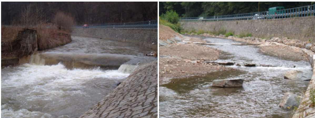
Abbildung 19: Wehranlage oberhalb Köttewitz vor Rückbau (links); Sohlgleite mit eingebauten Sohlriegeln, Niedrigwasserrinne und Störsteinen nach Rückbau (rechts)
