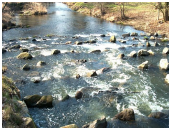
Abbildung 6: Sohlgleite an der ehem. Sohlenschwelle 15, Lausitzer Neiße (links) Sohlenrampe Paulsmühle in aufgelöster Bauweise (Riegelbauweise) an der Großen Röder (rechts) 1
