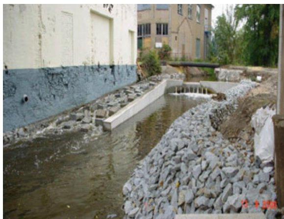
Abbildung 8: Mühle Pischwitz, Zschopau, Wehr mit Fischrampe (links) Wehr ehem. Schuhfabrik mit Fischrampe, Große Röder (rechts) 3
