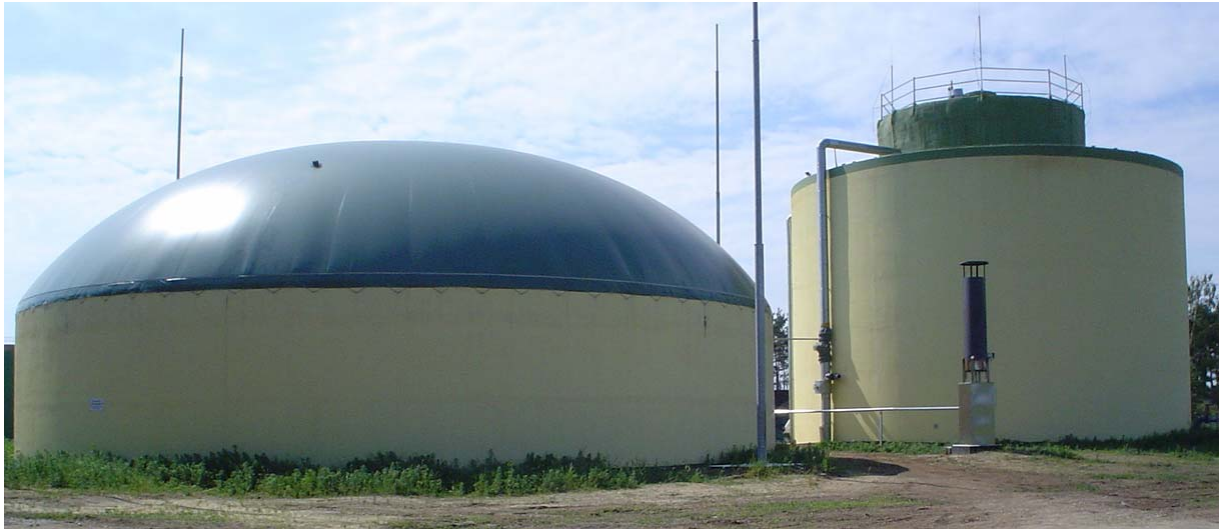
Abbildung 8: Gaslager (links) u. Pfefferkornfermenter (rechts) an der Biogasanlage der MKH Agrar-Produkte GmbH Kotten (bei Wittichenau, Landkreis Bautzen, Sachsen)
