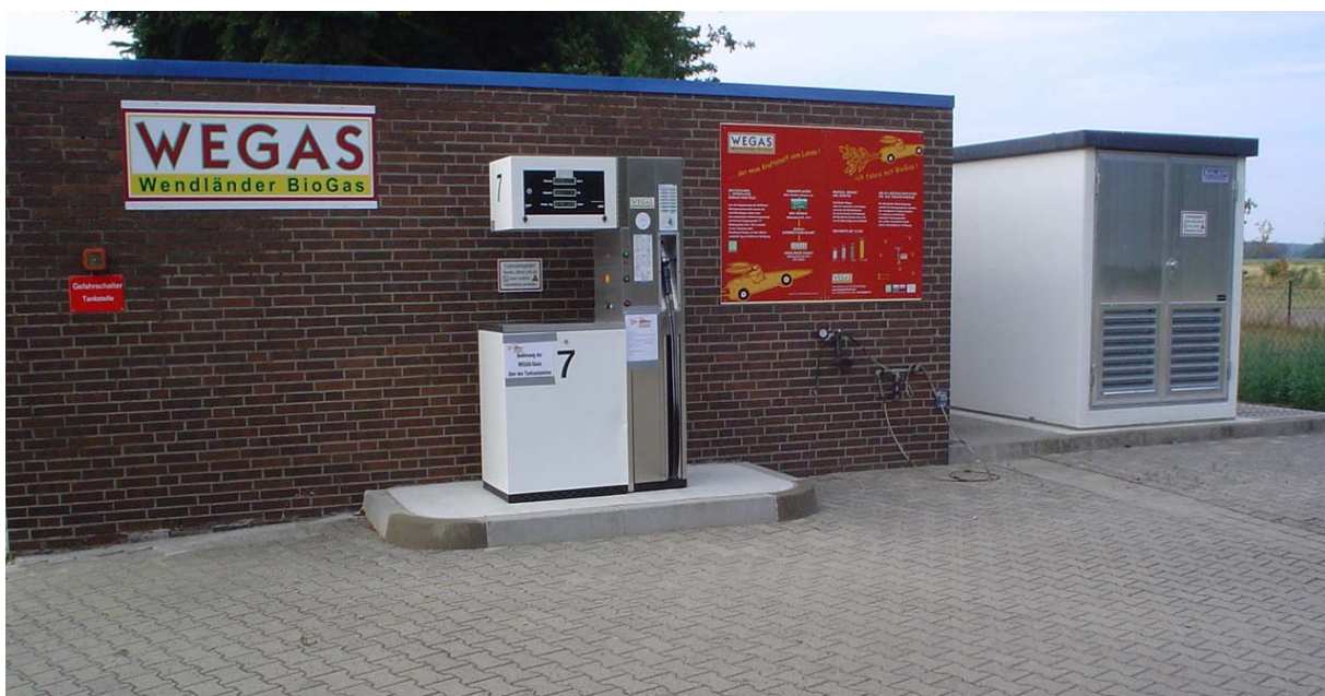
Abbildung 1: Wendländer BioGas-Tankstelle Raiffeisen Warengenossenschaft eG Jameln
