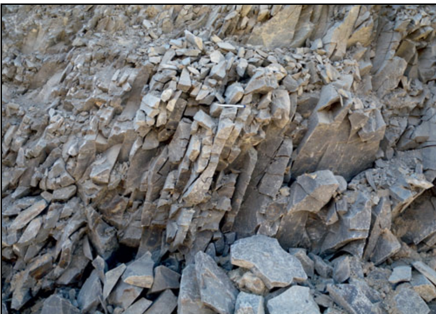
Abbildung 57: Steil NE-einfallende Klüftung, beginnend etwa 30 m im Liegenden der Lausitzer Überschiebung
