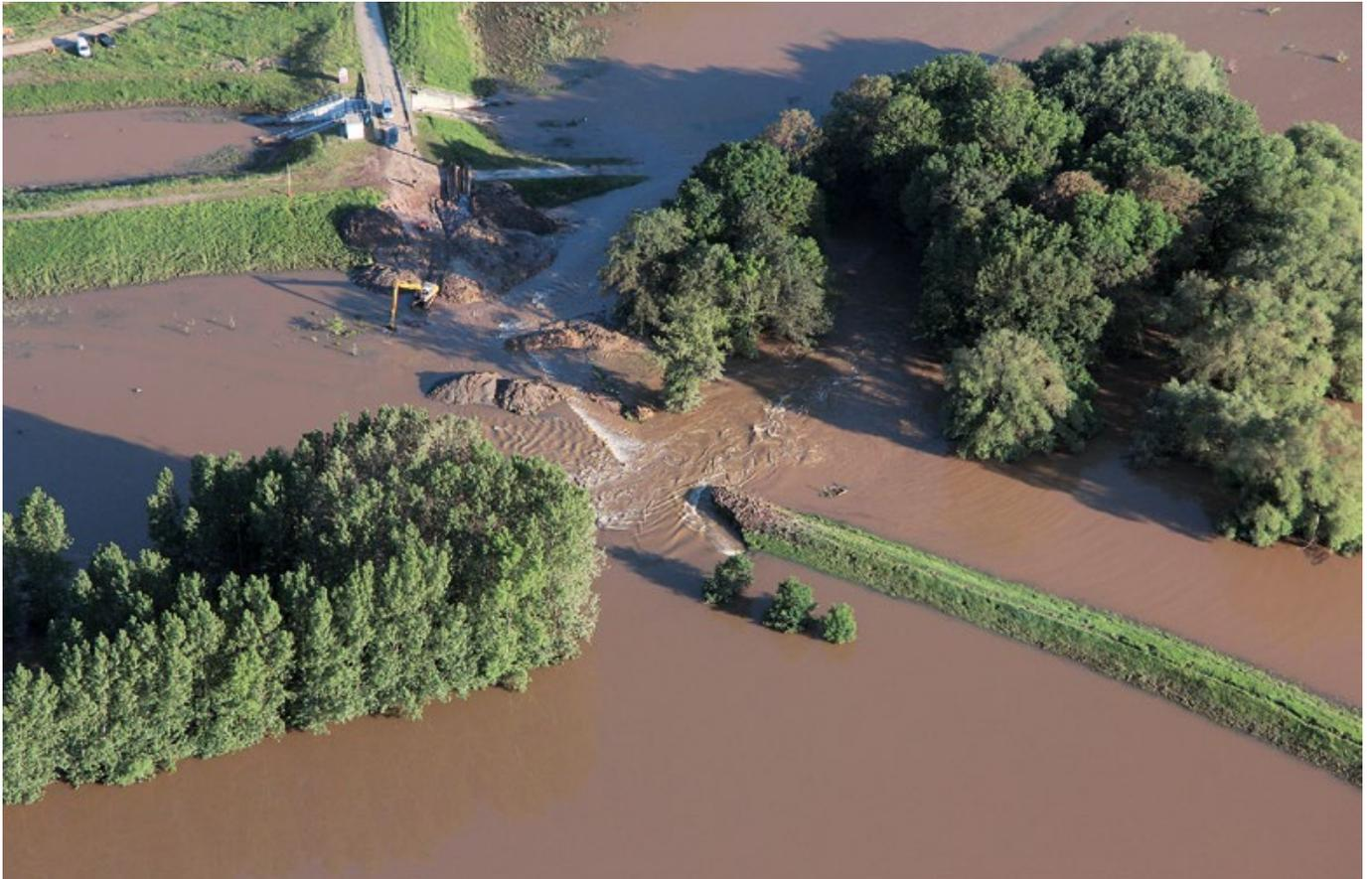
Abbildung 10-5: 1. und 2. Deichöffnung (Erdbauweise + Sprengung) am Siel Stöpselschleuse (Foto: LDS)
