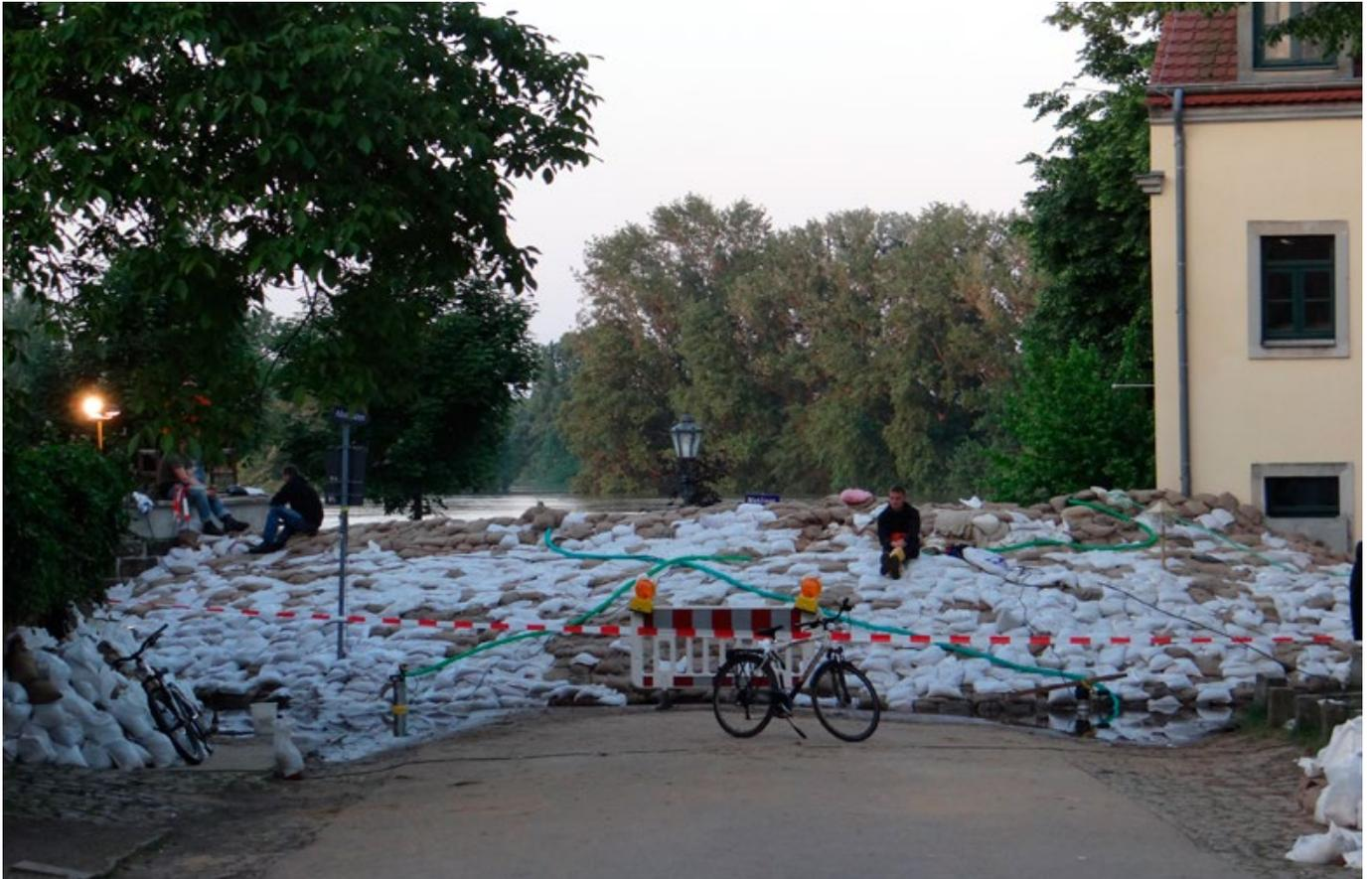
Abbildung 9-7: Sandsackverbau in Dresden-Pieschen (Foto: LfULG)
