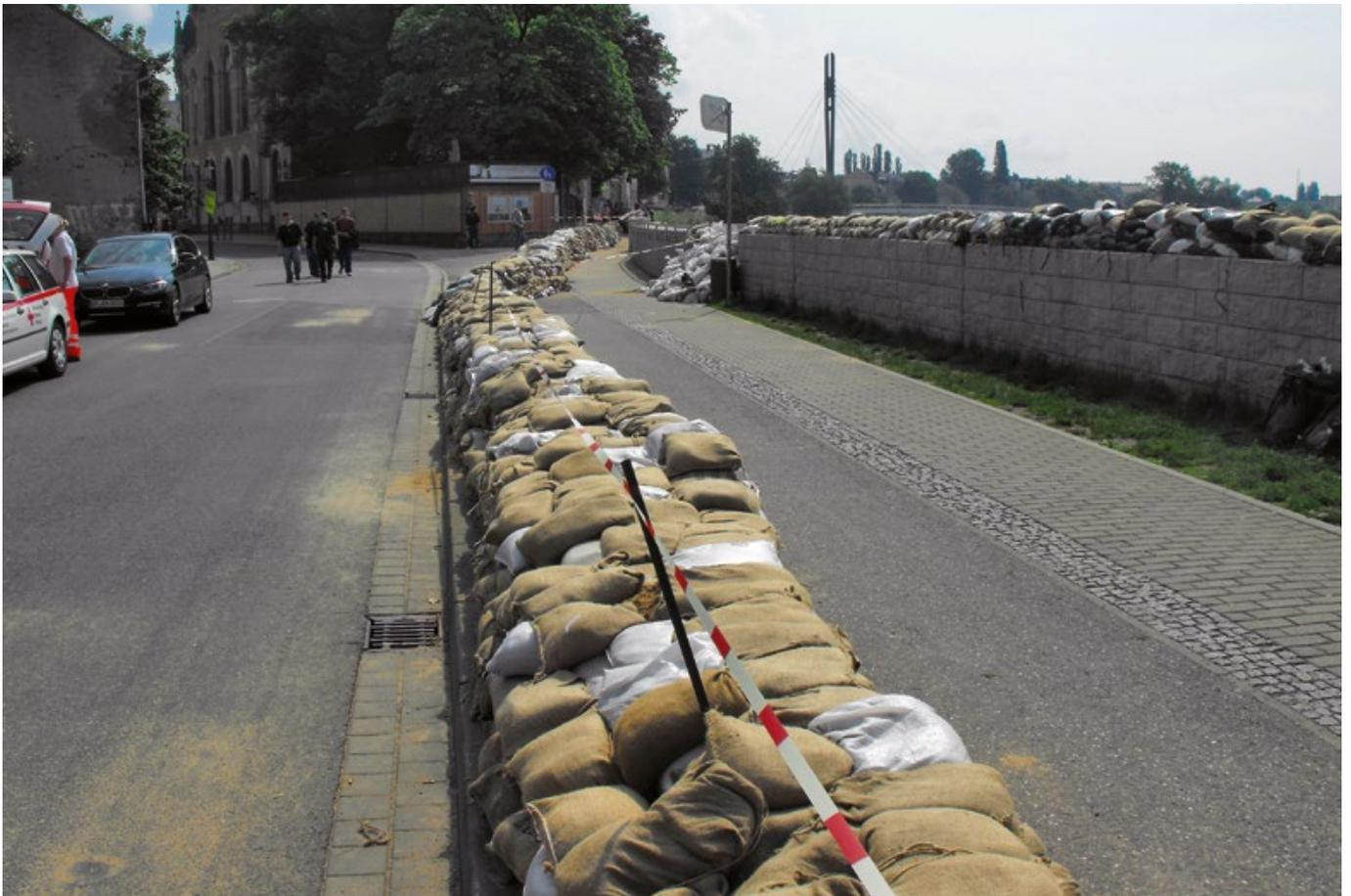
Abbildung 9-8: Sandsackverbau an der Kötzschenbroder Straße in Dresden (Foto: SMUL)
