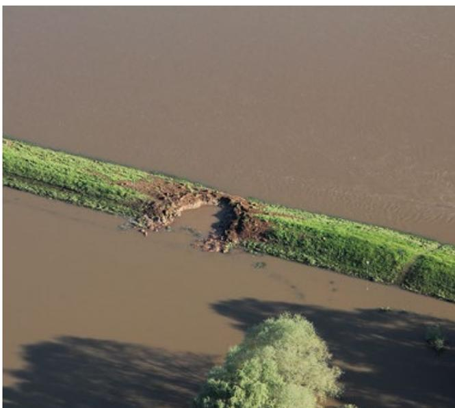
Abbildung 10-8: Zweite Sprengung am 05.06.2013 und Freispülen der verbliebenen Erdrippe am 06.06.2013 (Foto: LRA Nordsachsen)
