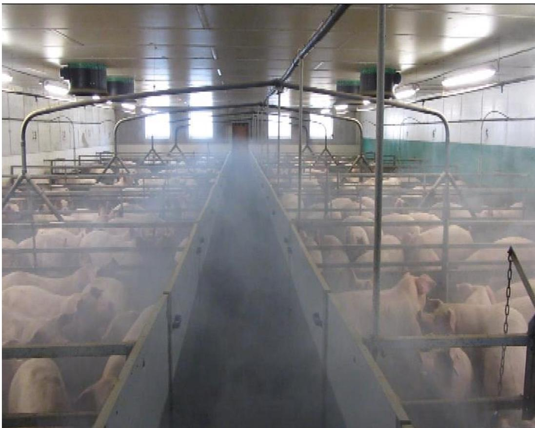
**Abbildung 6: Die Zuluft strömt aus den Stichkanälen über den Abteilgang in die Buchten (Nebeltest).**
