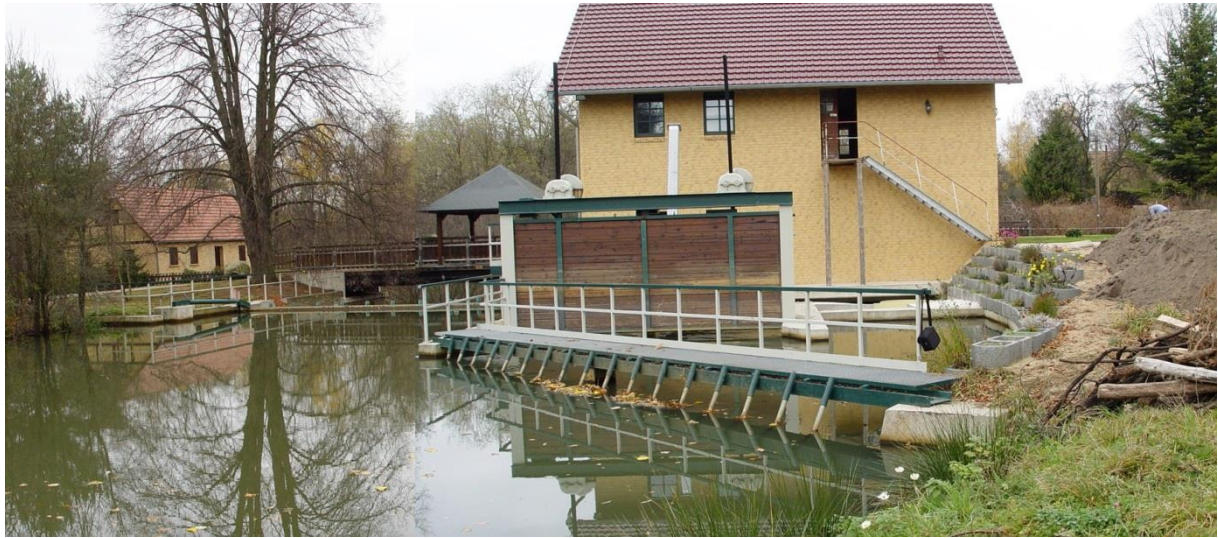
Abbildung 7: WKA Ruhlmühle/Spree - links Wehr, vorn rechts Grobrechen dahinter Holzschütz bzw. Einlauf Turbine mit Feinrechen, links daneben Einlauf bzw. Beginn Fischpass
