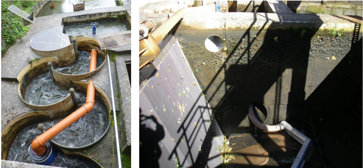
Abbildung 8: Fischpass mit verlängertem Aalrohr, Fangkammer [blaues Fass] und Reuse in der oberen Kammer [Gitter] des Fischpasses (links); Turbineneinlauf mit Feinrechen 15 mm, Aalrohr am Grund und den Wanddurchlässen zum Fischpass (rechts)
