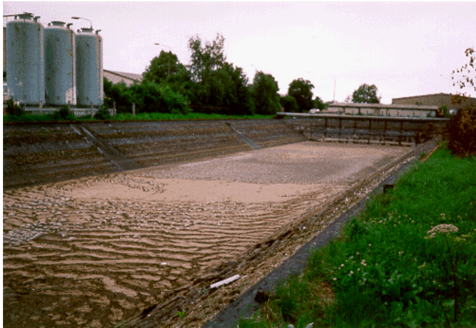
Abbildung 1.7 Erdbecken zur Lagerung des vergorenen Substrates
