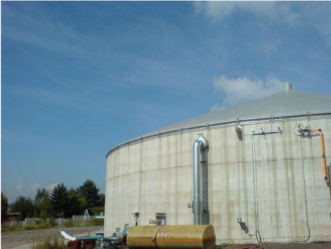
Abb. A.4.1 Endlager der Biogasanlage
