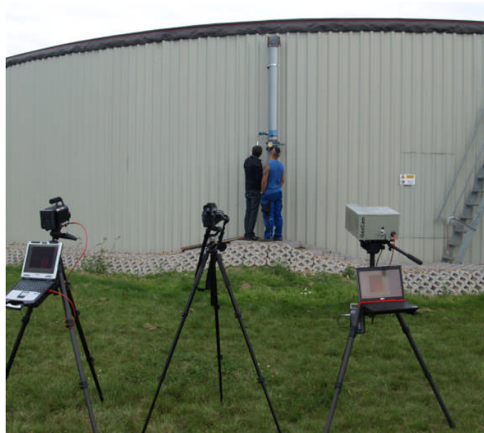
Abb. 7: Messanordnung zur Kamera- Vergleichsmessung bei gezielter Gasfreisetzung auf Anlage A5
