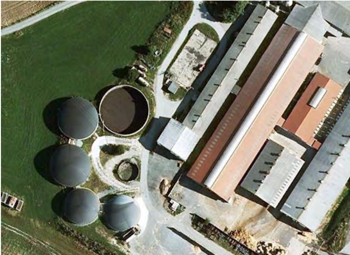
Abb. A.2.1 Übersichtsdarstellung der Biogasanlage (Endlager 1 u. 2 zum Zeitpunkt der Aufnahme noch nicht gebaut)
