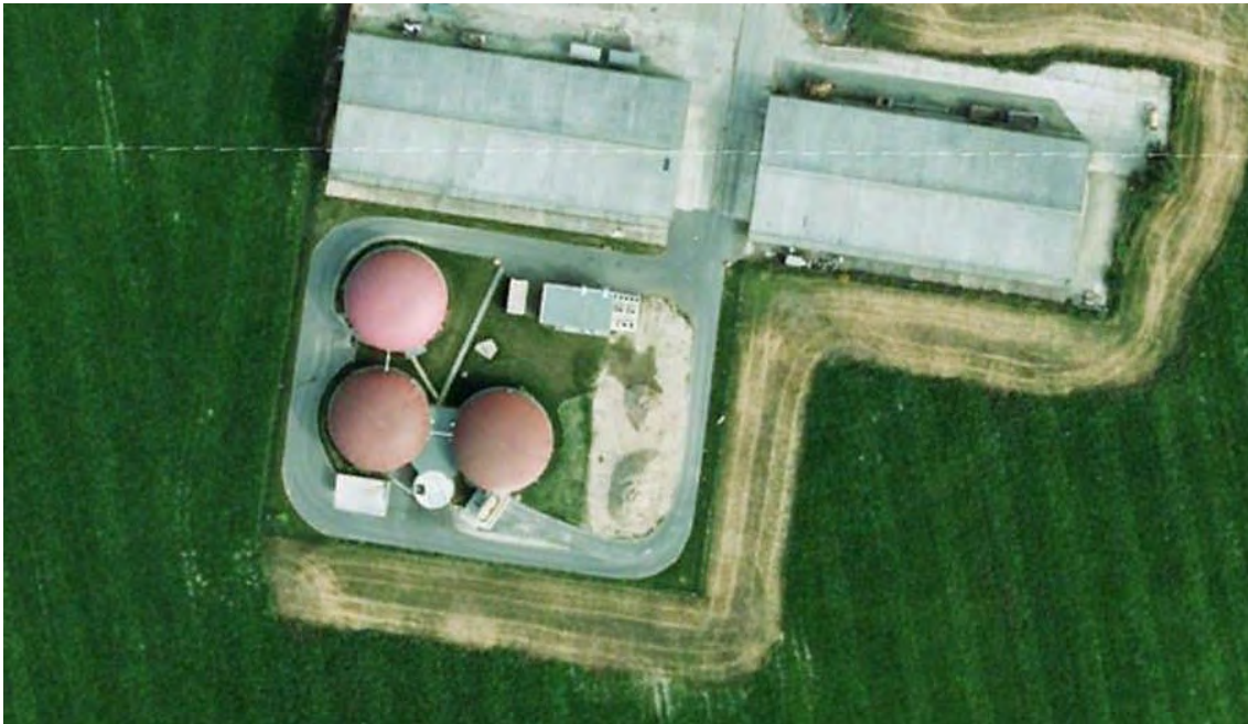
Abb. A.5.1 Übersichtsdarstellung der Biogasanlage (Endlager 2 zum Zeitpunkt der Aufnahme noch nicht gebaut)
