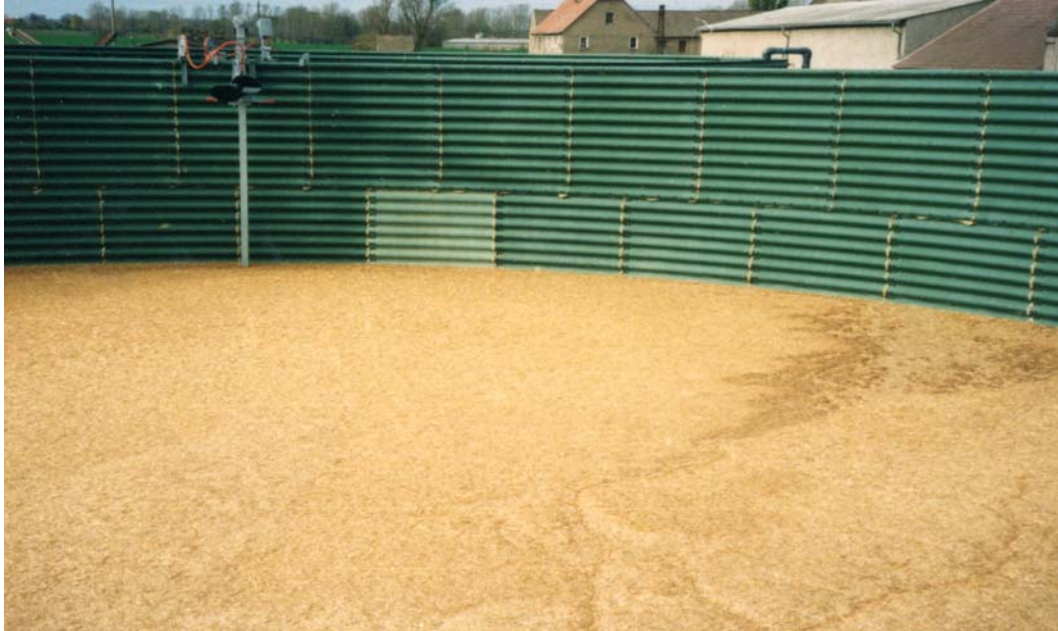
Foto 2: Abdeckung des Güllebehälters durch Strohhäcksel im Betrieb A
