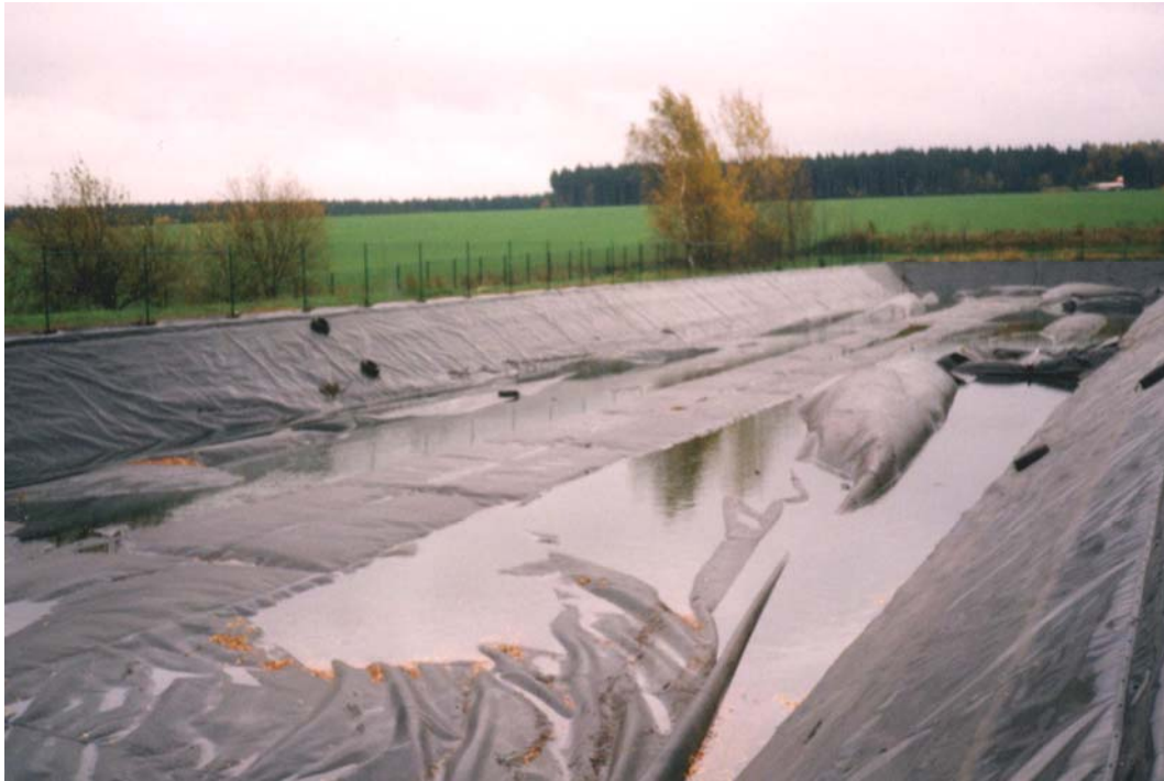
Foto 4: Abdeckung des Güllebehälters durch Schwimmfolie im Betrieb C
