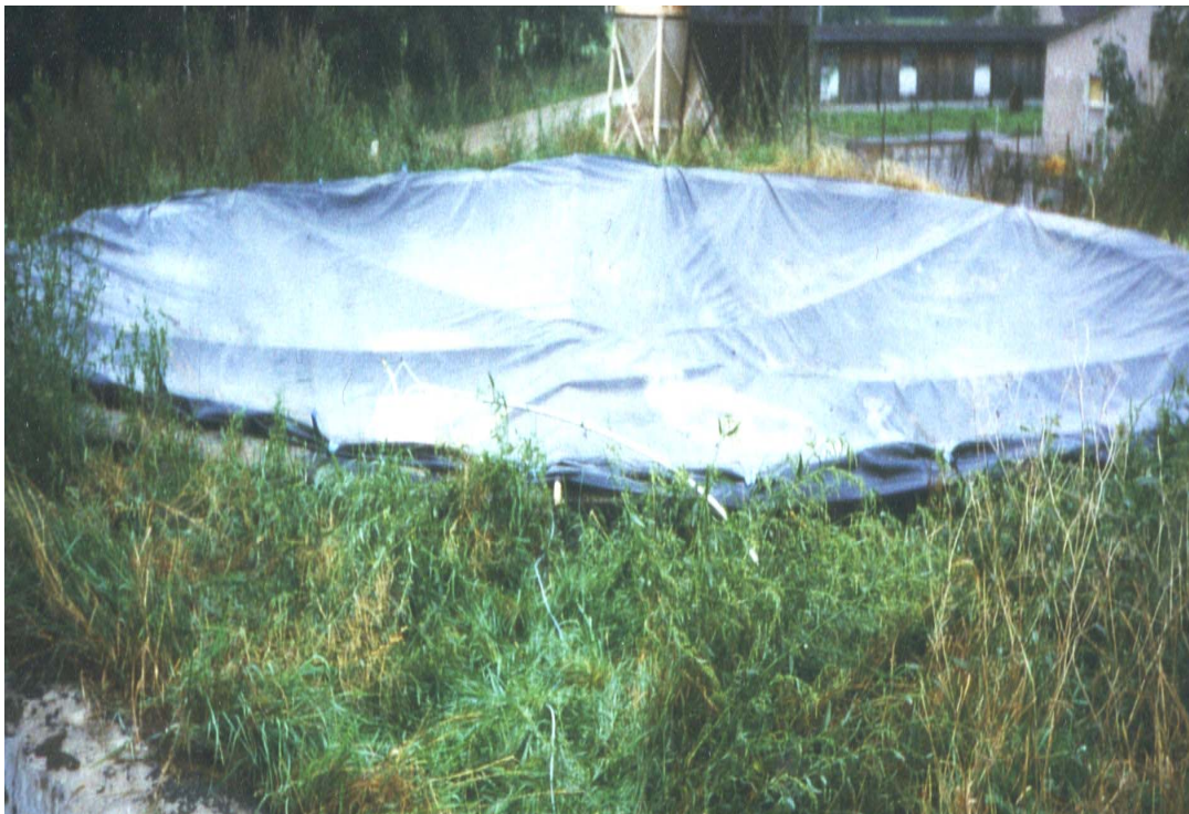
Foto 5: Abdeckung des Güllebehälters durch ein Zeltdach im Betrieb D
