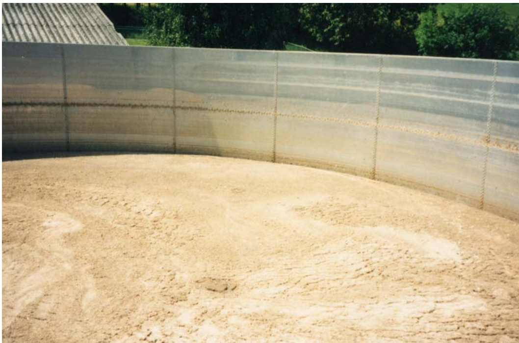
Foto 3: Abdeckung des Güllebehälters durch Pegülit M im Betrieb B
