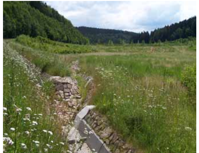
Abb. 9-8: Plateau der sanierten Luchsbachhalde mit Wasserableitungsgraben, Zustand 2011
