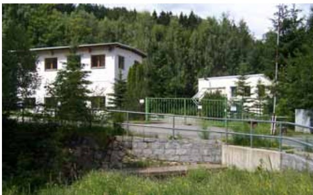
Abb. 9-4: Konventionelle Wasserbehandlungsanlage, Zustand 2011
