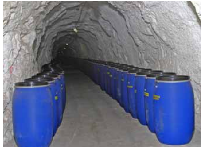
Abb. 9-5: Untertägige Einlagerung der Rückstände aus der Wasserbehandlung
