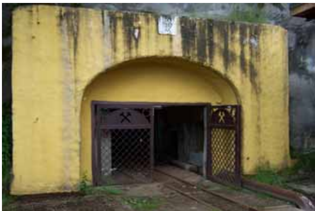
Abb. 9-1: Mundloch Stolln Pöhla, Zustand 2011
