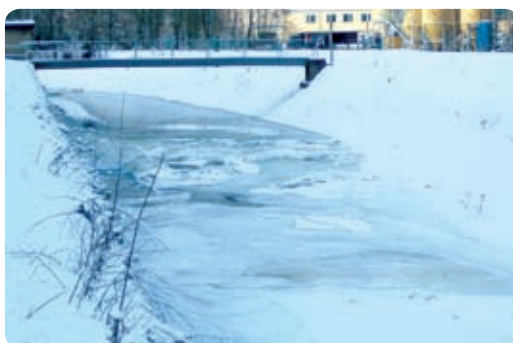
Eisversatz mit Aufstau im Zulaufkanal am Pegel Schönheide
