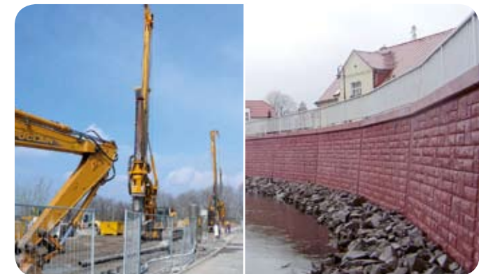
Bauarbeiten für den Hochwasserschutz und neue Hochwasserschutzmauer
