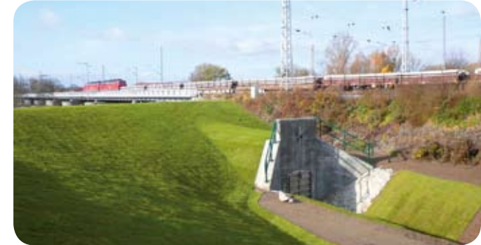
Deichneubau an der Vereinigten Mulde
