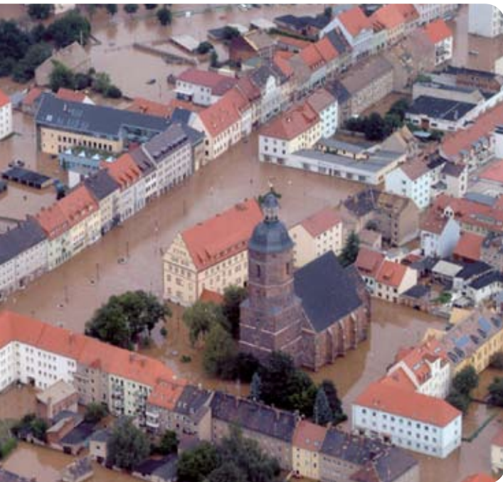
Überflutete Stadt Eilenburg im August 2002 1
