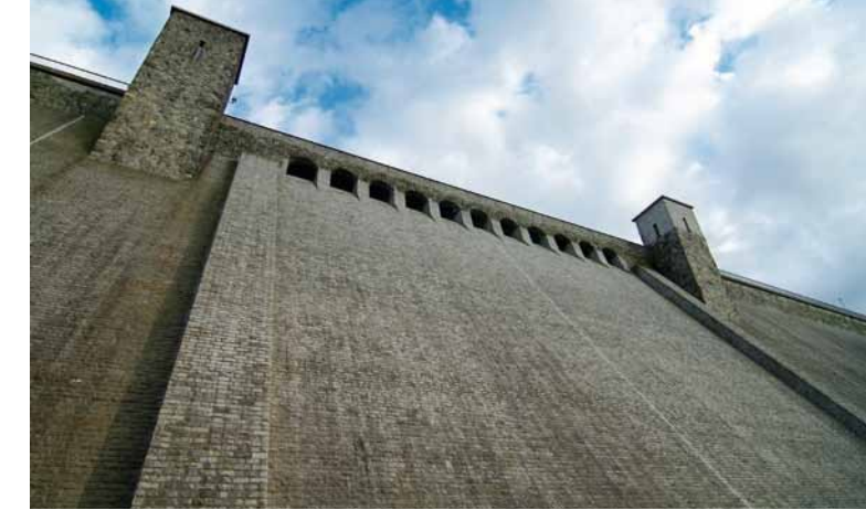
Talsperre Lehmühle – Hochwasserentlastungsanlage
