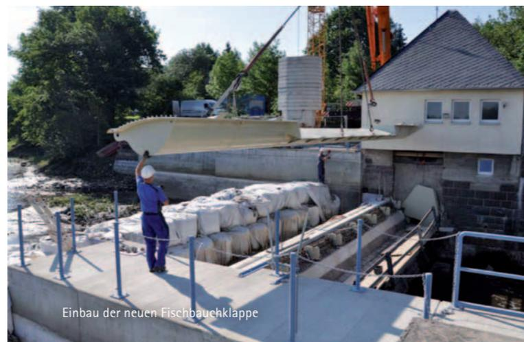
Einbau der neuen Fischbauchklappe
