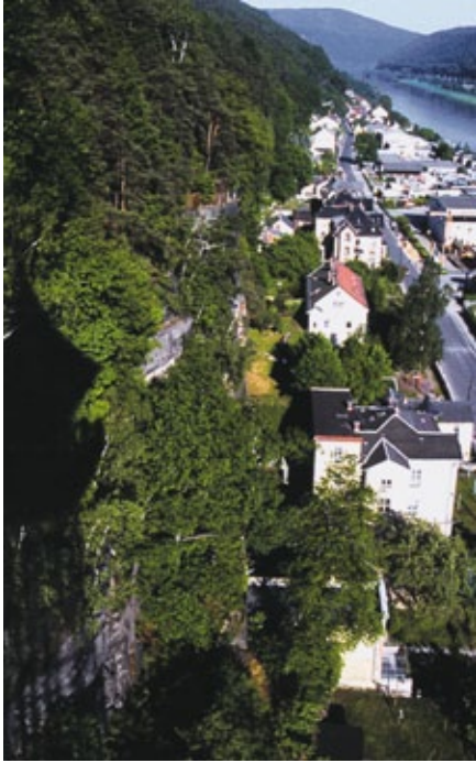
Wald schützt bauliche Anlagen vor Steinschlag
