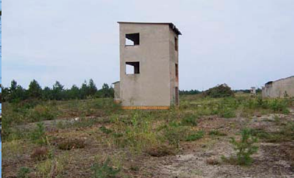
Abriss und Entsiegelung militärischer Altlasten
