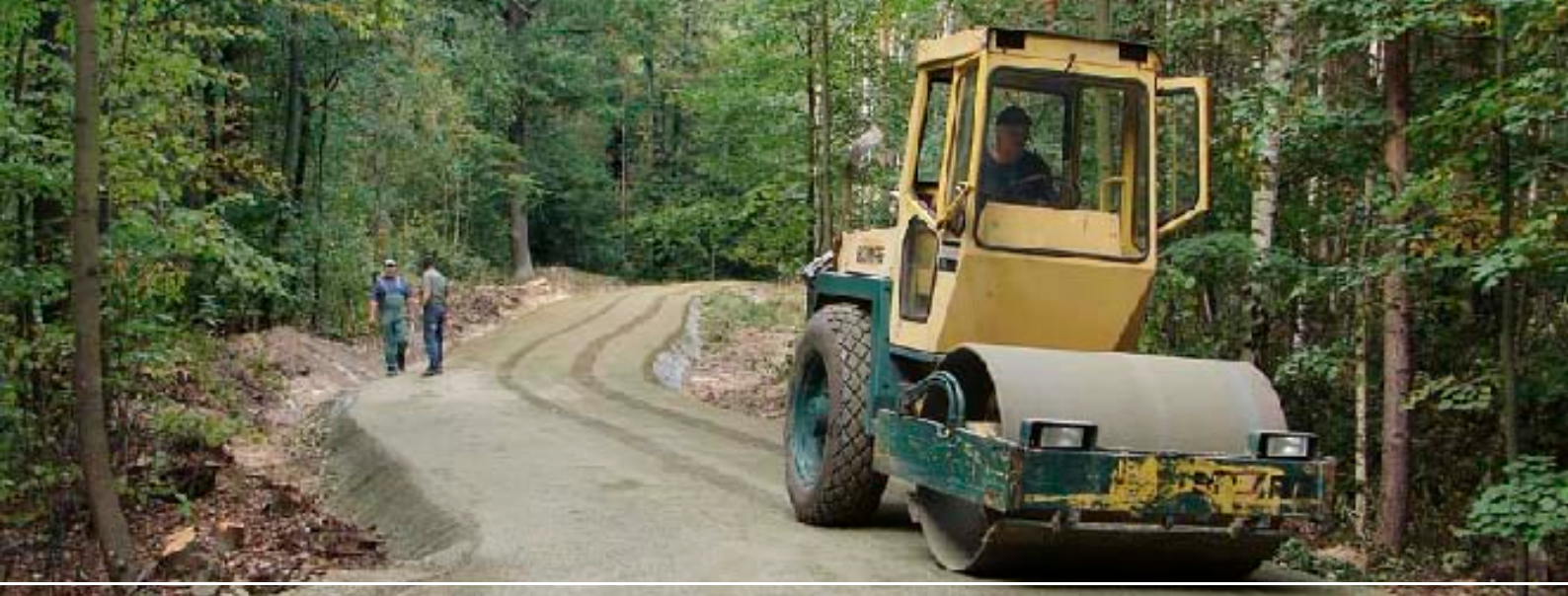
Forstwirtschaftlicher Wegebau ist einer der Hauptbestandteile der forstlichen Förderung
