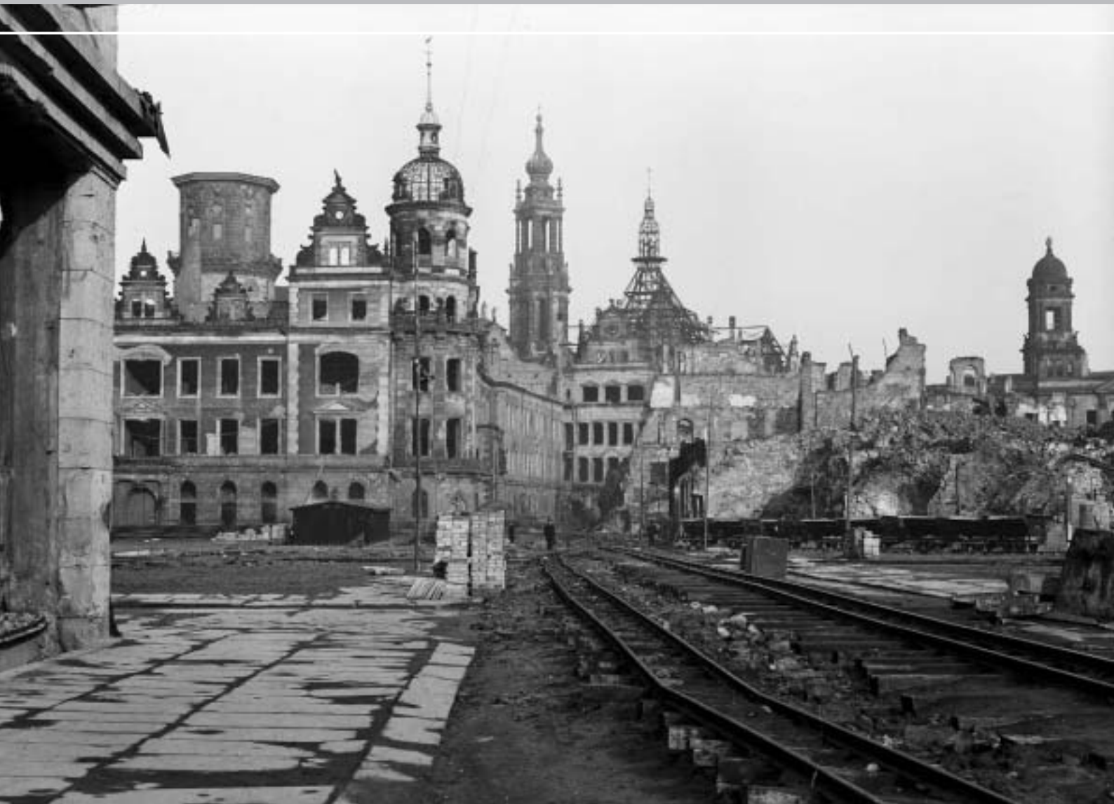
25 Blick in die Schlosstraße nach Norden, im Vordergrund die Trümmerbahnstrecke T 1, die vom Altmarkt durch Schlosstraße und Devrientstraße zur Kippe im Ostragehege verlief
