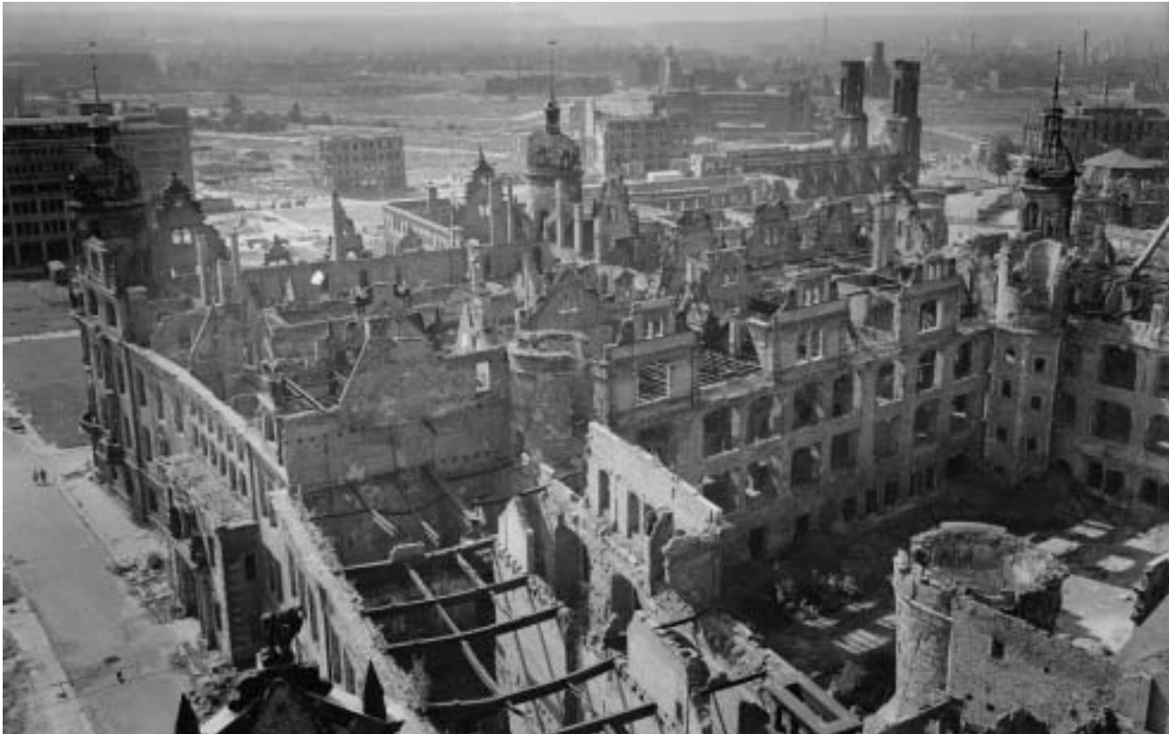
26 Blick auf das Schloss von Nordost, im Vordergrund der zerstörte Ostflügel, im Hintergrund die von Ruinen beräumte Innenstadt
