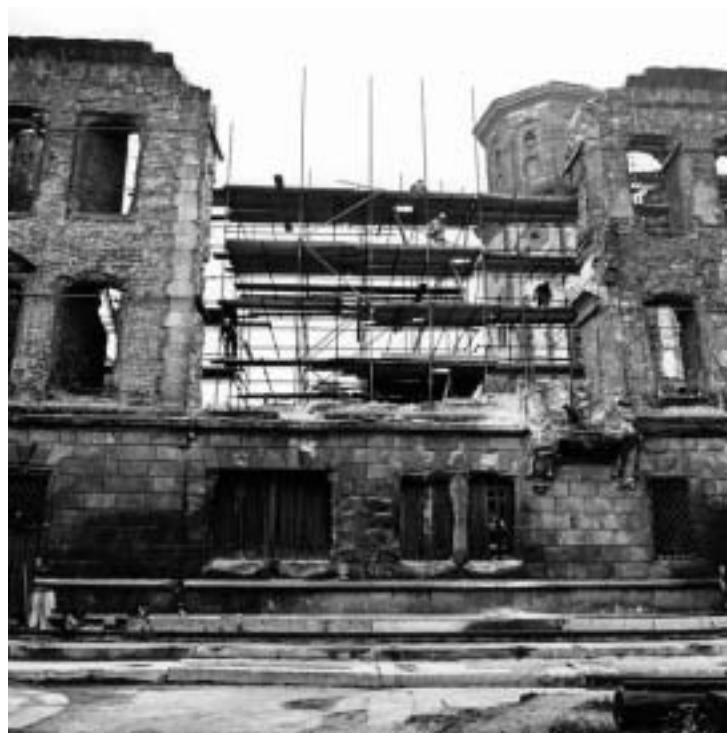
36 Abbrucharbeiten am Ostflügel zur Schaffung des »Technologischen Durchbruchs« (Juli 1985)
