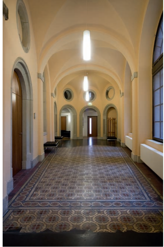
70 Östliches Erdgeschoss des Südteils, die ursprünglichen Bodenfliesen von Villeroy und Boch wurden durch Terrazzo ergänzt
