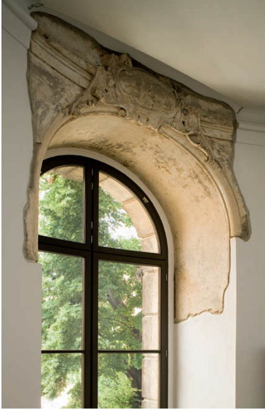
69 Stuckkartusche im südwestlichen Eckturm, 1. Obergeschoss
