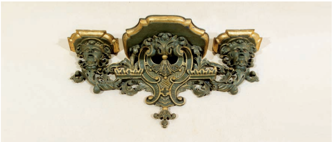
89 Dreiarmige Konsole, oben: die verlorenen Teile wurden durch Schnitzer angearbeitet und nachgebildet unten: Endzustand nach Ergänzung der Farbfassungen
