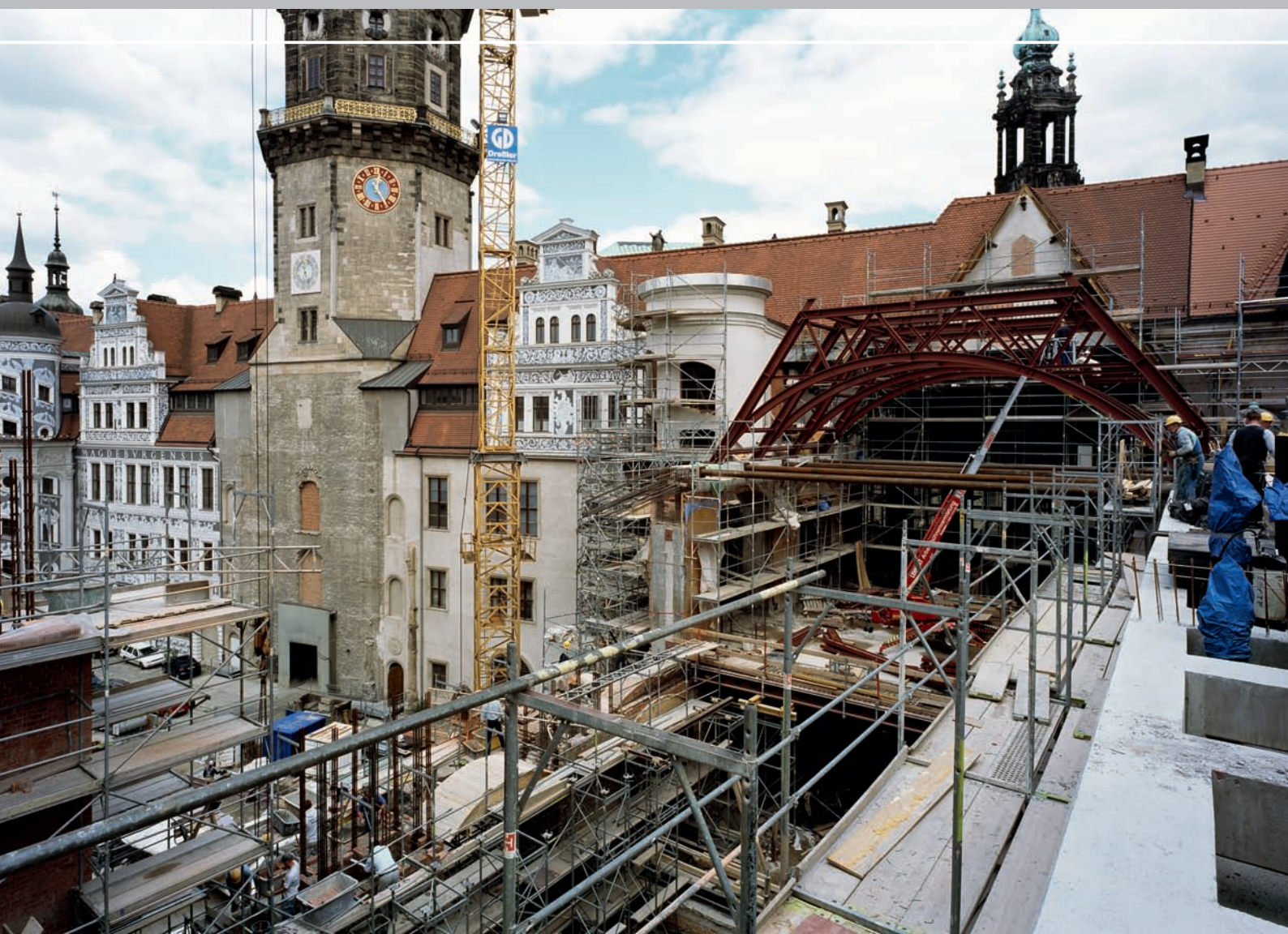
07 Blick vom sich im Rohbau befindlichen Ostflügel in den Großen Schlossohof (Juni 2006)
