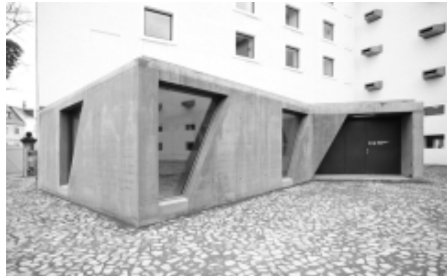
NEUES WERKSTATTGEBÄUDE AUF DEM ALTEN SCHLOSSHOF FOTO: AFF ARCHITEKTEN, BERLIN
