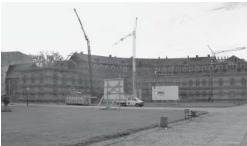
VORBEREITUNG DER ENTKERNUNG VON GEBÄUDE 71 UND 72 FOTO: VOLKER JÄGER
