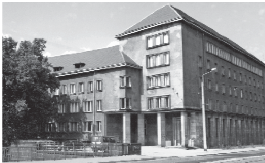
DAS GEBÄUDE DES STAATSARCHIVS IN WROCLAW, UL. POMORSKA 2 FOTO: RYSZARD BACMAGA
