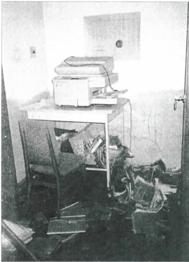
Wasserstand ca. 1,20 m – Kopierer trotz hoher Position beschädigt, Papier und Stühle durch Wasserkraft bewegt
