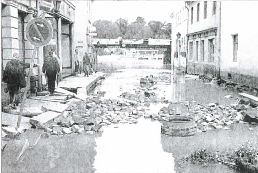
Zerstörte Zufahrtsstraße zum Stadtarchiv nach dem Gottleubahochwasser
