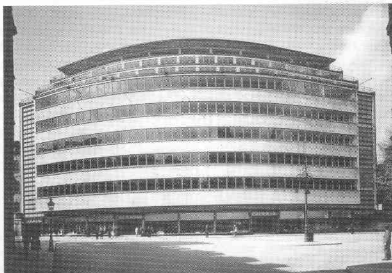
Das Kaufhaus Schocken in Chemnitz kurz nach der Eröffnung 1930 StAC, 31451, Schocken, Nr. 270
