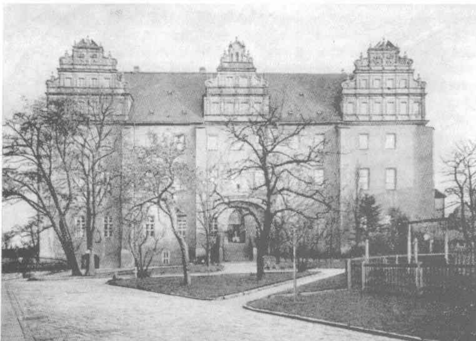
Das denkmalgeschützte Hauptgebäude der Ortenburg in Bautzen wird im Erdgeschoß von der Außenstelle Bautzen und im nördlichen Flügel der ersten Etage vom Stadtarchiv Bautzen genutzt Foto: Bildstelle Sächsisches Staatsarchiv Dresden
