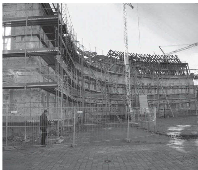
Umbauarbeiten für die Zentralwerkstatt in Schloss Hubertusburg (Foto: V. Jäger)
