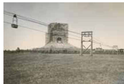
Von der Fa. Bleichert gebaute Seilbahn zur Errichtung des Völkerschlachtdenkmal (Vorlage: Staatsarchiv Leipzig, 20781 Bleichert Transportanlagen GmbH, Leipzig, Nr. 432)
