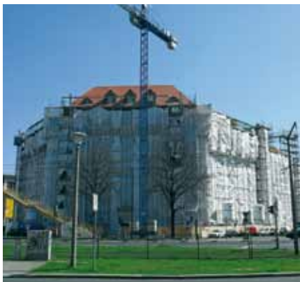
Sanierung des Hauptstaatsarchivs Dresden (Foto: M. Harring)
