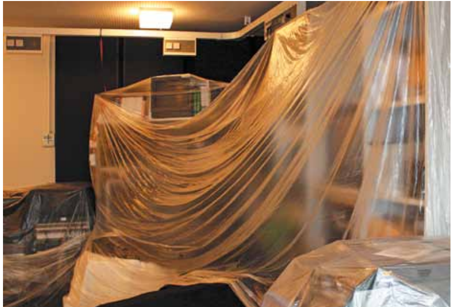
Schutz des Videostudios vor Baustaub (Foto: Stefan Gööck)
