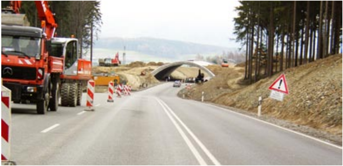
Betonunterbau der Grünbrücke
