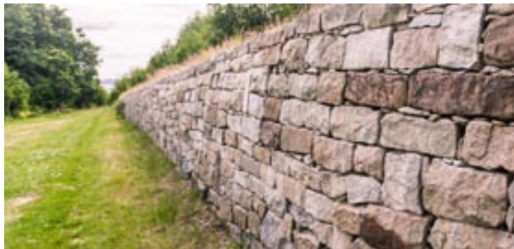
neu errichtete Parkmauer
