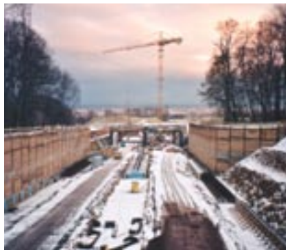
offene Baugrube des Tunnels
