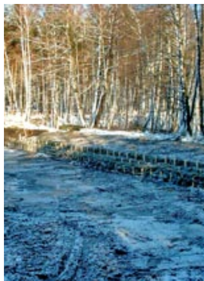
ingenieurbiologische Ufersicherung, Bauphase 2004
