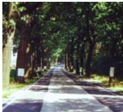
Zustand Roteichenallee vor der Straßenbaumaßnahme
