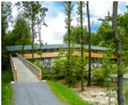
Haselmausbrücke nach Fertigstellung
