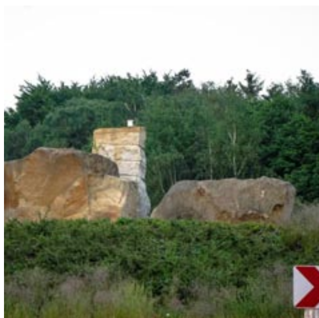
Zustand Kreisverkehr, ein Jahr nach Abnahme
