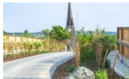
Heckenbrücke Friedrichswalde, Bereich mit Wirtschaftsweg und beidseitigen Hecken als Leithilfen
