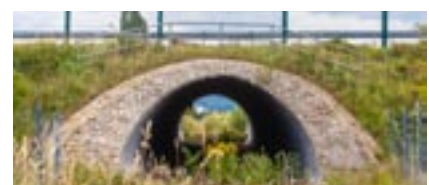
Tierdurchlass unter der Autobahn
