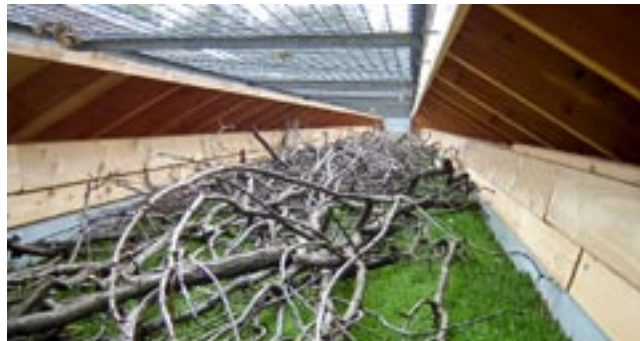
Laufstrecke der Haselmaus innerhalb der Brücke
