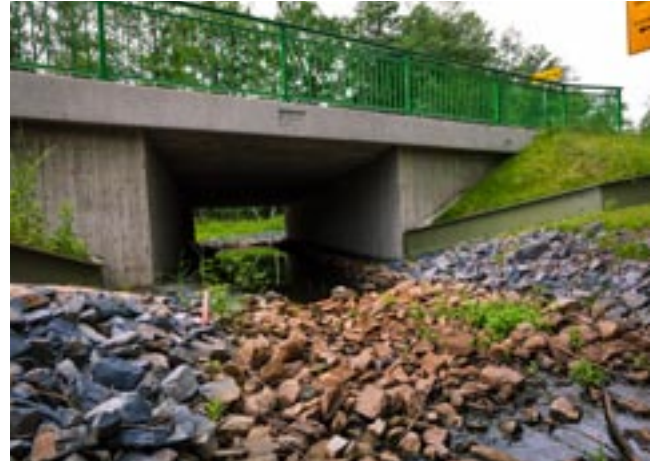
Brücke über den Lockwitzbach mit Bermen und Leiteinrichtung
