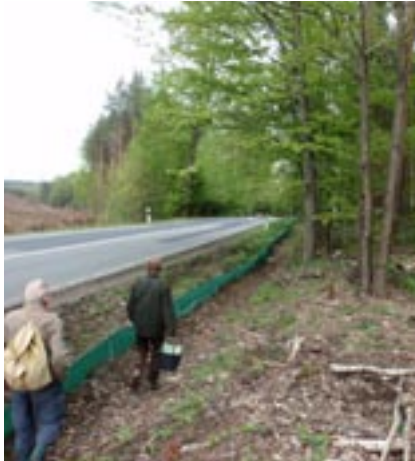
temporäre Absperrung während der Bauphase
