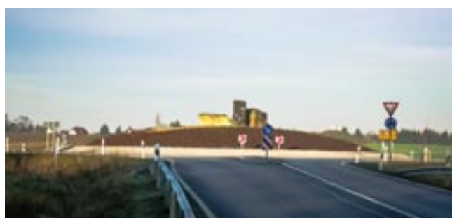
Zustand Kreisverkehr nach Abnahme
