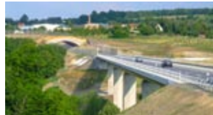
Bahretalbrücke mit Heckenbrücke im Hintergrund
