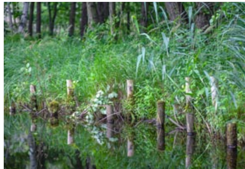
ingenieurbiologische Ufersicherung, Zustand 2012
