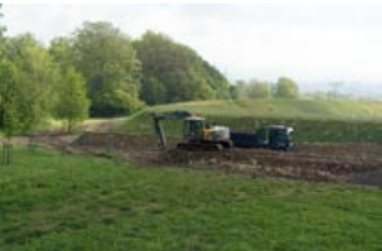
Bau der neuen Parkmauer am östlichen Tunnelportal
