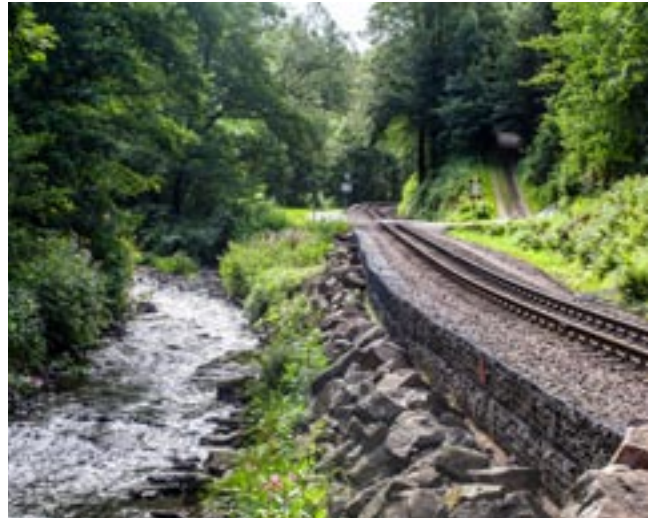
Rote Weißeritz neben der Bahnstrecke der Weißeritztalbahn
