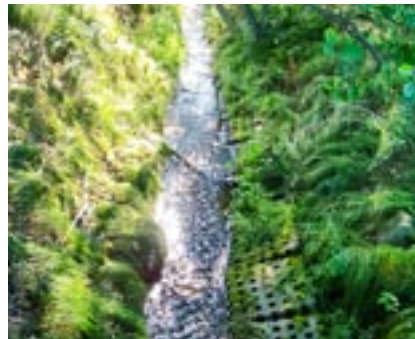
Befestigung mit Betonplatten
