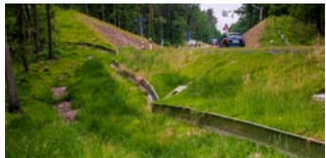
Verlauf der Leiteinrichtung im bewegten Gelände
