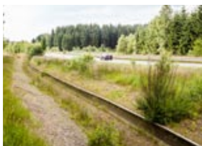
Amphibienleiteinrichtung entlang der S 303
