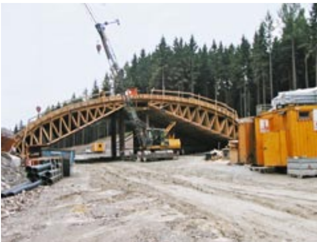
konstruktive Errichtung der Grünbrücke
