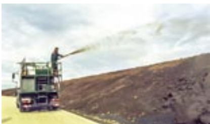
Nassansaatverfahren 2001 an der A 17
