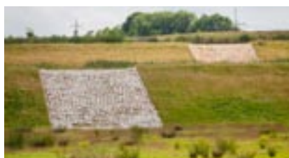
Überlauf zur nächstniederen Terrasse
