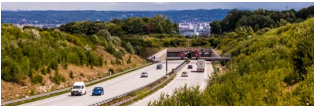
Blick auf den Landschaftstunnel Altfranken
