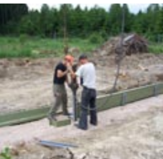
Herstellung der Kleintierschutzanlage
