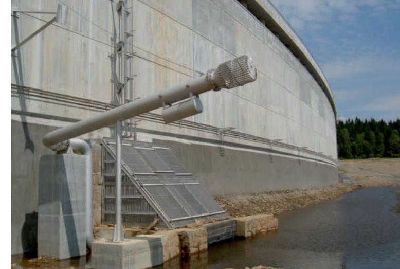
Anlage zur Rohwasserentnahme bei entleerter Talsperre
