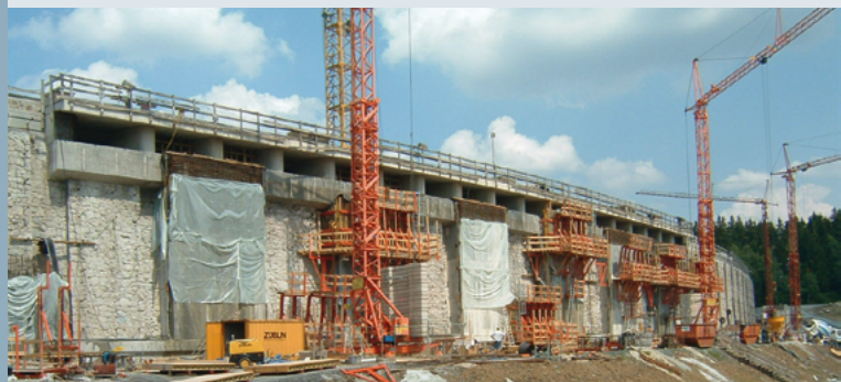
Instandsetzung der Wasserseite, Juli 2006
